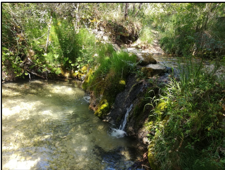
Figure 47 : Seuil en pierres avec chute d'un mètre (T2)
