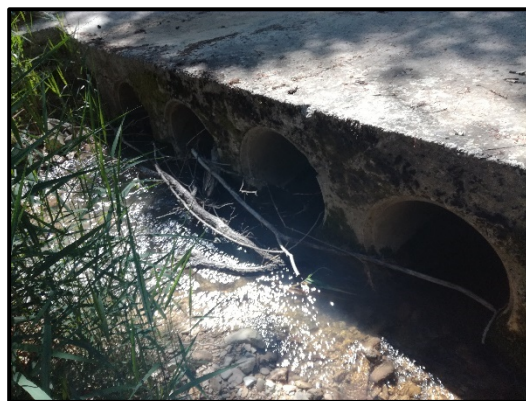
Figure 71 : Passage à gué busé en aval (T2)
