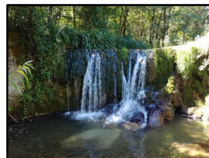
Figure 64 : Seuil avec 4 mètres de chute (T6)
