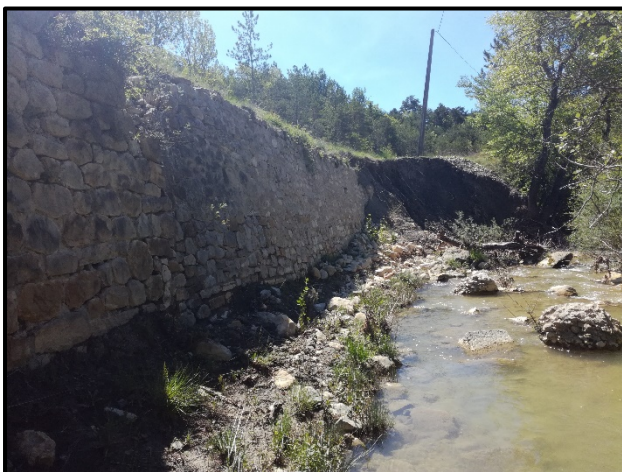
Figure 12 : Mur en pierre rive gauche (T4)
