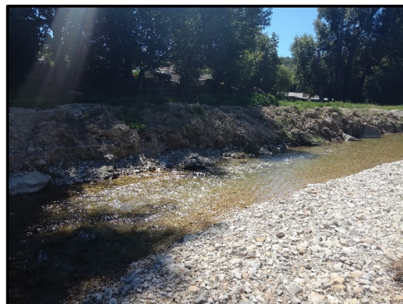
Figure 25 : Enrochement en bordure de lit proche d'une habitation (T7)
