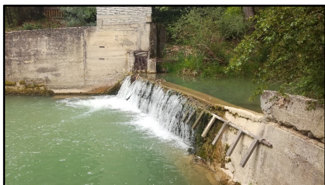
Figure 35 : Seuil artificiel anciennement utilisé pour adduction d'eau (T10)
