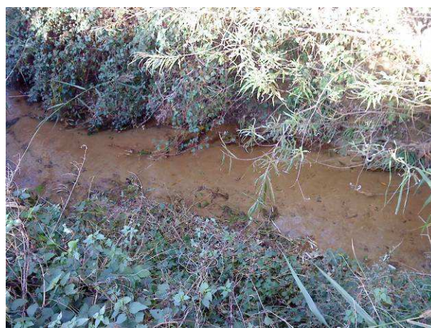
Dépôts sableux généralisés lorsque la pente est faible (aval ligne TGV)
