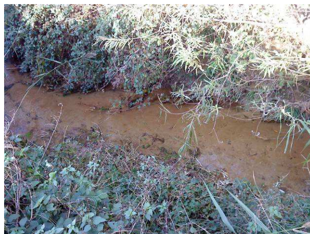
Dépôts sableux généralisés lorsque la pente est faible
