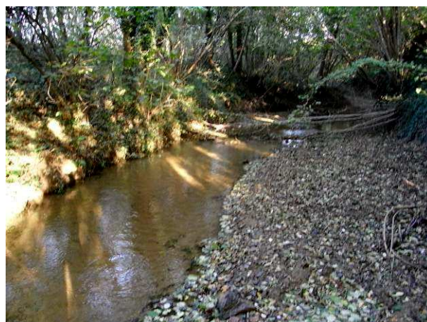
Dépôts sableux généralisés en aval de la RD 53 (17)
