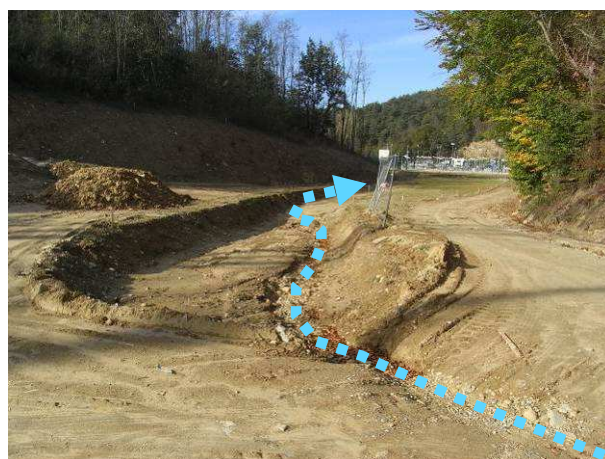
Terrassement au niveau de la première plateforme de Storengy favorisant la production sédimentaire
