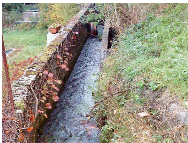
Cours d'eau canalisé en amont du moulinage
