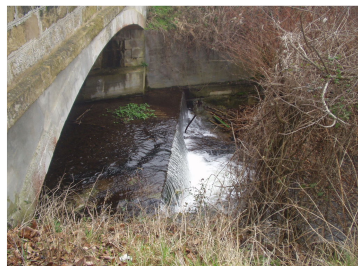
Seuil sous le pont de la RD1
