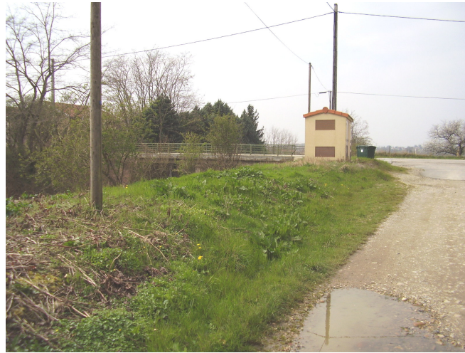
Levée de terre longue de 80 m en amont du pont de la RD139 (DolD3)
