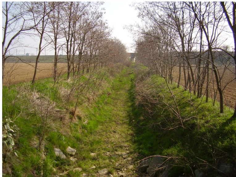
Le Dolure recalibré en aval du TGV (DolD17 et DolG10)
