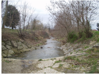
Aval du gué des Iles
