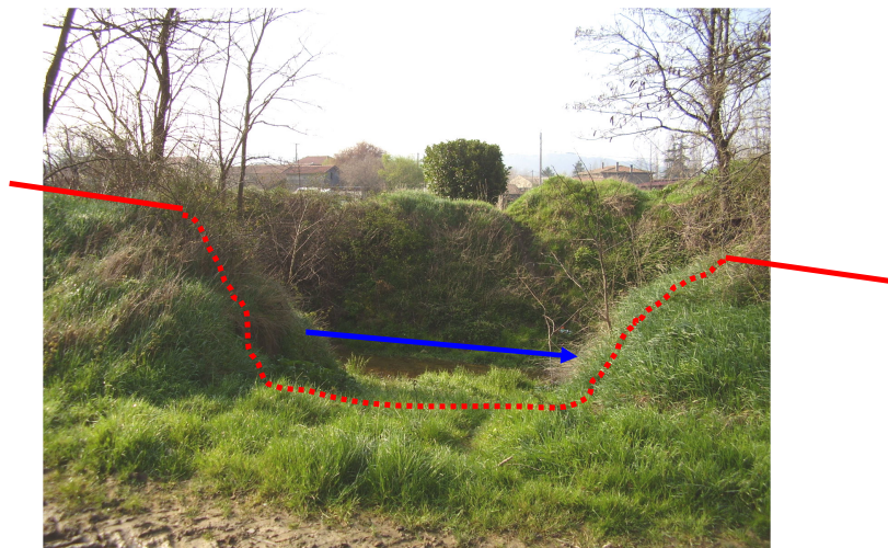
Brèche dans la digue DoID12 – Accès au cours d'eau créé par les agriculteurs
