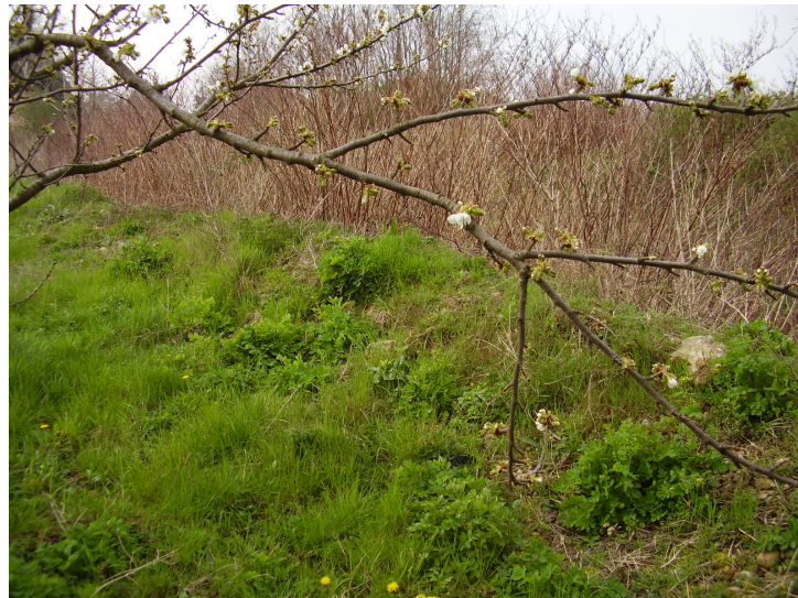
Merlon de berge en rive gauche en amont gué au lieu dit de l'île (DolG3)
