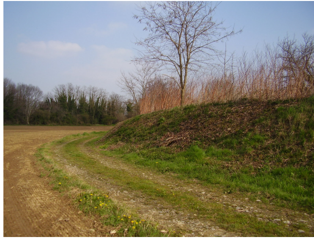
Digue reconstitué suite à la crue de 1993 (DoID9)
