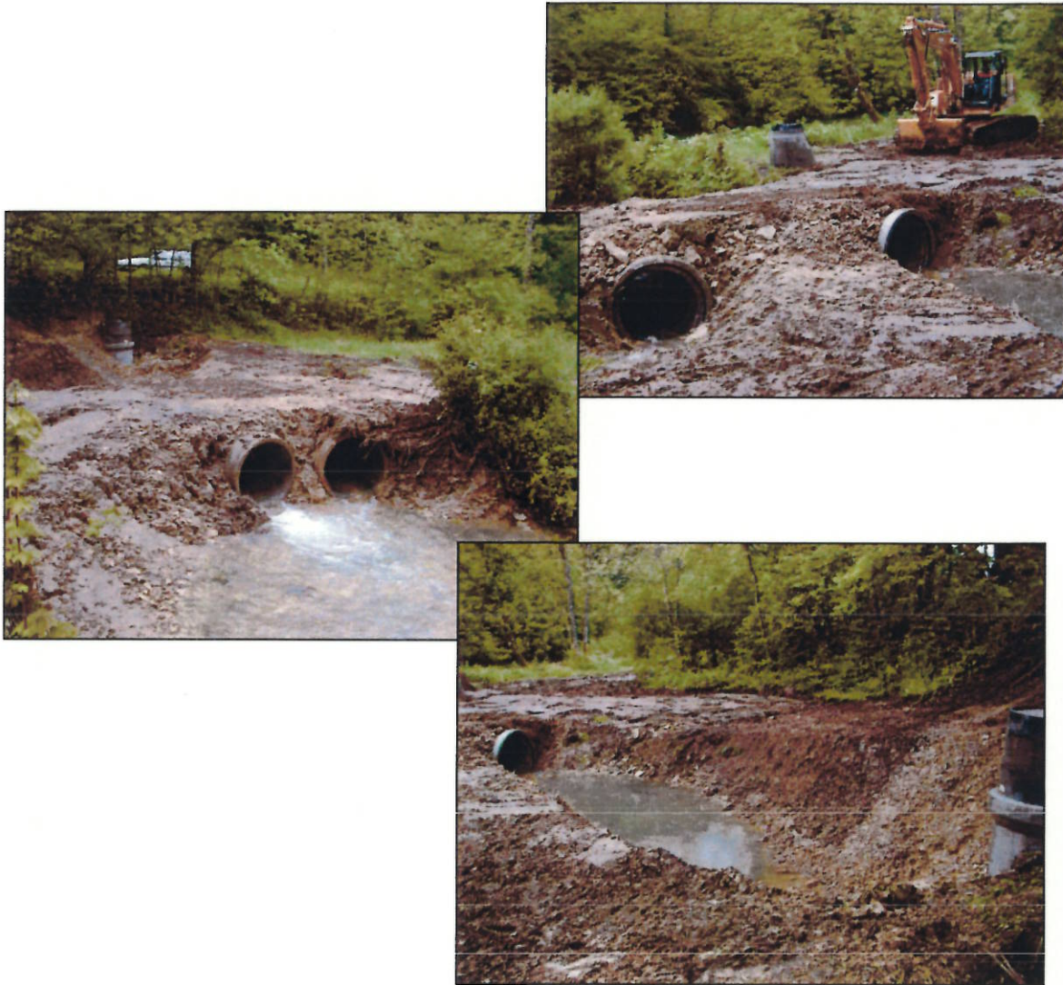
Photo 2 : Intervention à la pelle mécanique et mise en place de 2 passages busés Le 17 mai 1999 sur l'émergence de Froidefontaine
