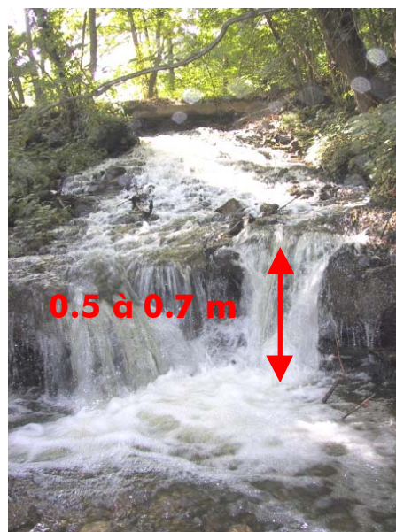
Ancien seuil affouillé difficilement franchissable pour le poisson (Bilaize)
