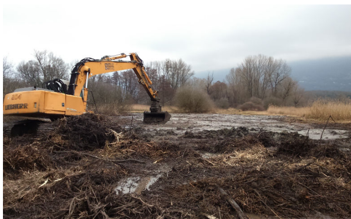
Figure 32 : dessouchage et nivellement (EID)
