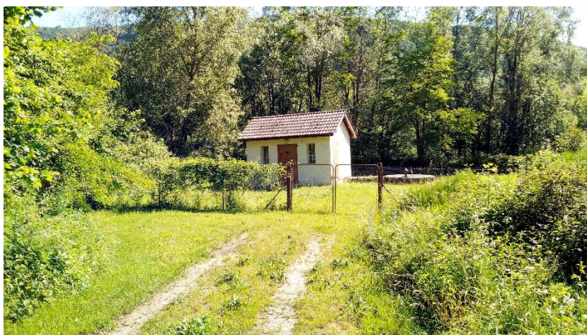
Local technique du captage et bonde à modifier
