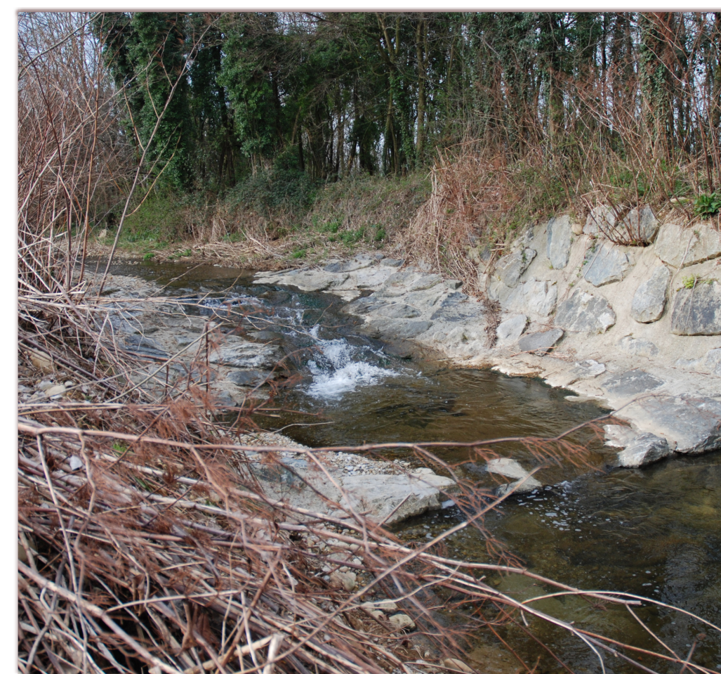
L'ouvrage (ROE 11322) avant travaux
