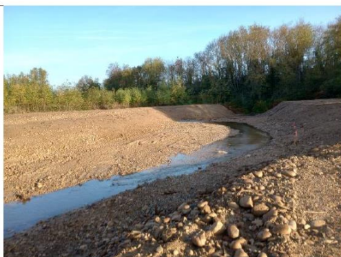
Chantier vue vers l'aval
