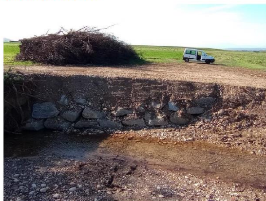
Enrochement en amont rive gauche
