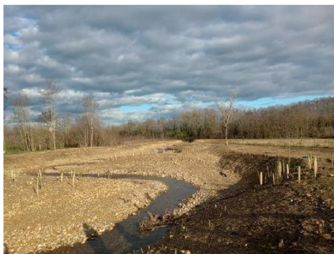
Chantier vue vers l'aval
