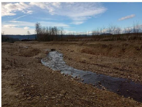
Chantier vue vers l'amont
