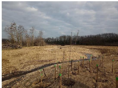
Chantier vue vers l'amont
