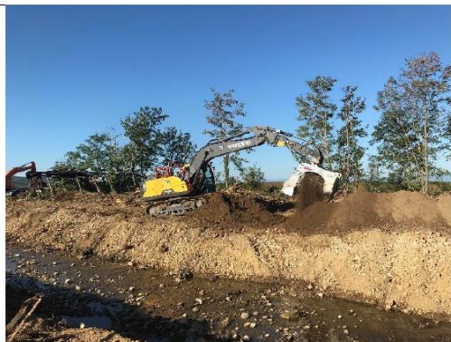
Criblage des matériaux pollués
