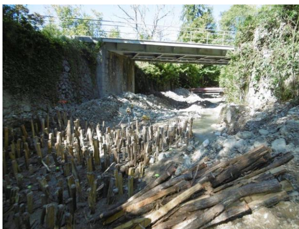
FIGURE 2 : PRESENTATION D'UN TAPIS DE PIEUX BATTUS – SOURCE OFB
