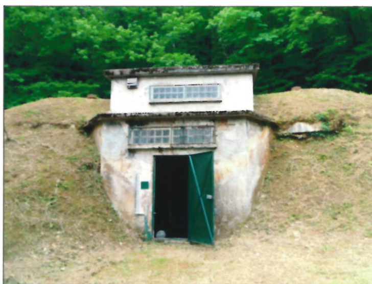
Fig. 1. Réservoir du Villard existant
