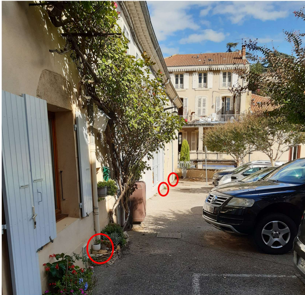
Figure 21 : Toitures raccordées à l'EU - Pl. de l'Eglise à Etoile
