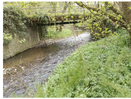
8. Ouvrage franchissement accès moulin 12/04/2022
