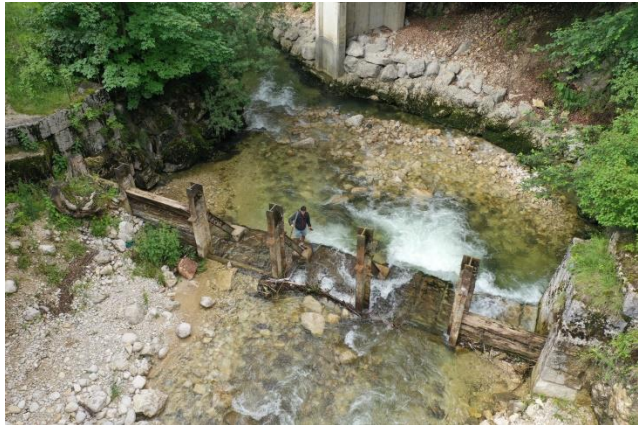
Figure 15 : Déstockage des sédiments grossiers dans la retenue du seuil de Douanes
