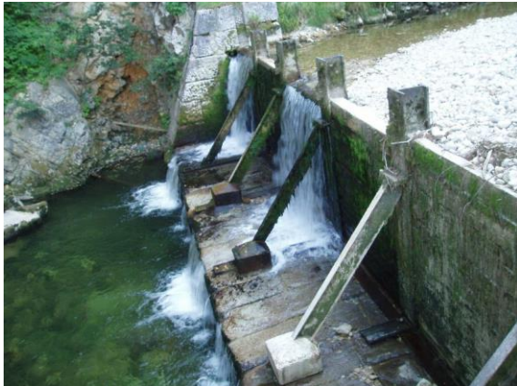
Figure 15 : Déstockage des sédiments grossiers dans la retenue du seuil de Douanes
