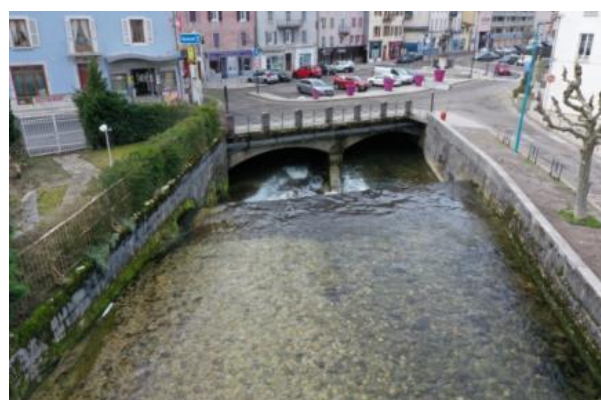
Figure 39 : Seuil en amont de la place Lissac
