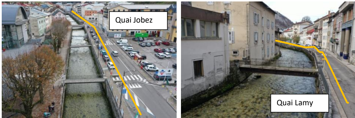
Figure 37 : Vues des berges de la Bienne au niveau du tronçon médian
