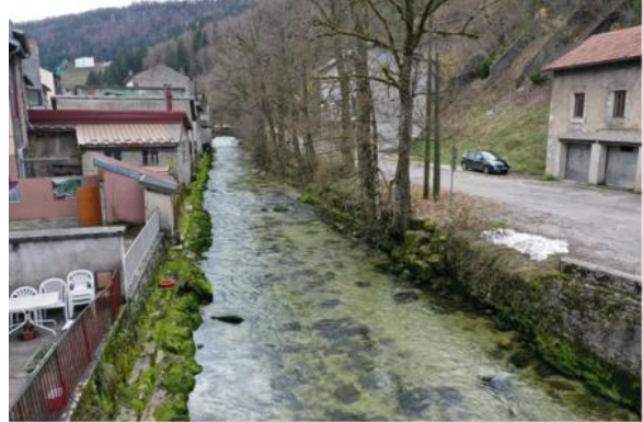
Tronçon aval – partie aval
