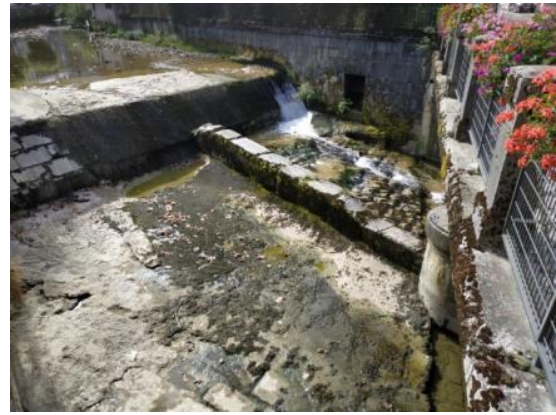
Figure 40 : Seuil Lissac à l'étiage
