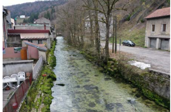
Tronçon aval – partie aval
