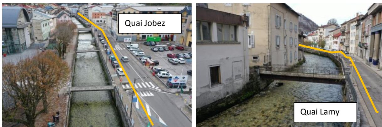
Figure 25 : Vues des berges de la Bienne au niveau du tronçon médian
