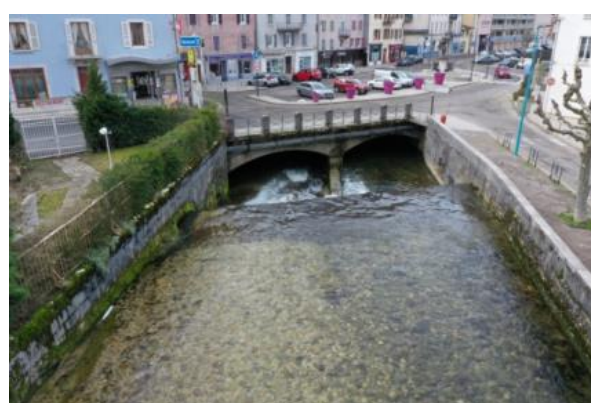
Figure 27 : Seuil en amont de la place Lissac
