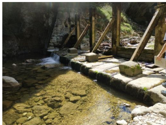
Figure 6 : Seuil des Douanes à l'étiage
