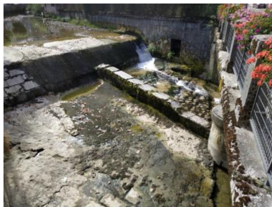
Figure 28 : Seuil Lissac à l'étiage
