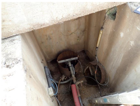
Figure 1 : Prélèvement au forage de Villeneuve le 28 mars 2022, eau de très bonne qualité pour tous les paramètres, sonde de mesure piézométrique du réseau de bassin et installation de pompage pour la géothermie et l'arrosage
