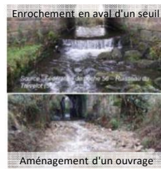
Aménagement d'un ouvrage
