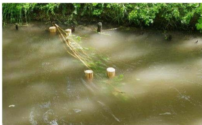
Exemples d'épis avec fagots de saules (Source : Fédération pêche Lozère à gauche / SAGEBA à droite)
