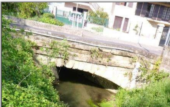
Pont sous dimensionné sur l'Ozon, (SOM, été 2021)
