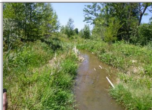
Berges recalibrées sur l'Ozon, (SOM été 2021)
