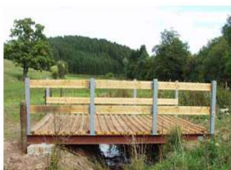
Passage en bois pour bétail et engins agricoles avec poutrelles métalliques et fondations en béton
