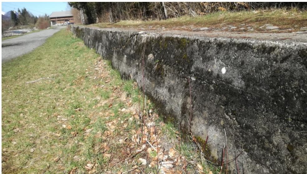
Figure 68: Réparation du système d'endiguement du GME suite à la crue de 1968.
