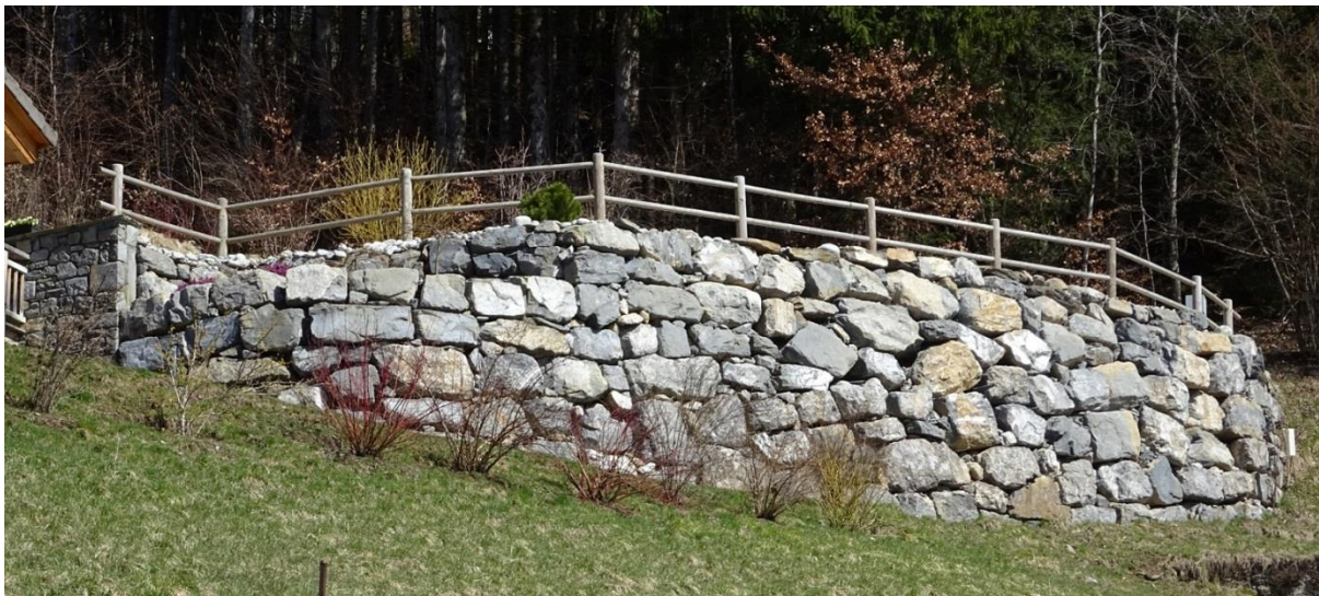
Figure 9 – Constitution d'un mur poids avec de gros blocs de pierre variés. Source : Egis
