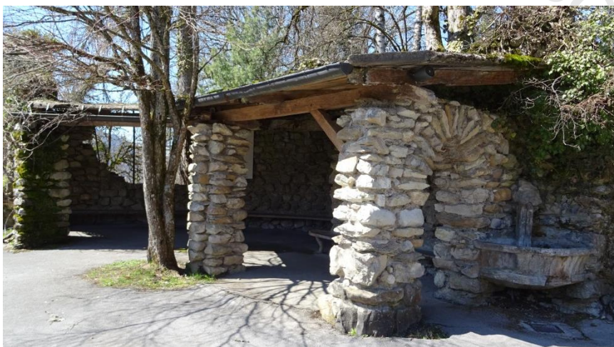
« Fabrique » construite sur les ruines du Château de Montanier sur les hauteurs du jardin botanique - Source : Egis
