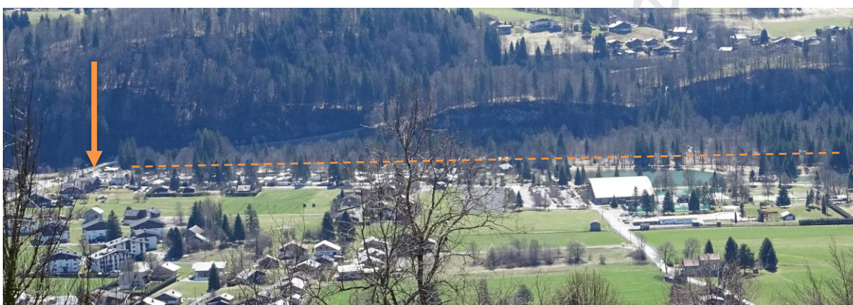
Vue 06 (zoomée) – Depuis les Combes à 900m d’altitude (c’est-à-dire 220m plus haut que la plaine) on constate une covisibilité avec l’ouvrage de franchissement du Giffre par la RD4 à gauche dans l’image (flèche orange). On perçoit également la ripisylve du Giffre représenté ici par un pointillé orange. Source : Egis
