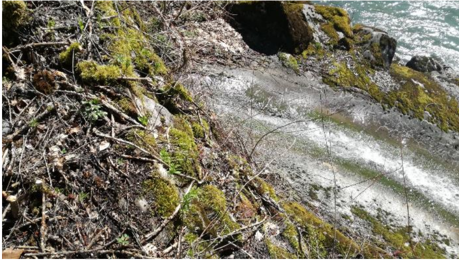
Figure 94: Ouvrage de rejet - PT8 - Digue Lac aux Dames amont.
