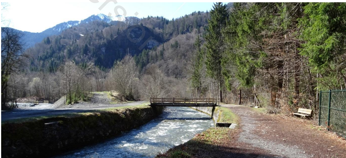
Vue 14 – La passerelle en bois qui est le seul ouvrage enjambant le Clévieux dans cette séquence, permet d'accéder aux deux sentiers de randonnées venant des bords du Giffre à l'est. Source : Egis
