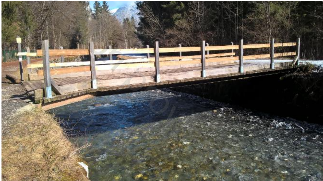
Figure 30: Passerelle aval dans sa configuration actuelle
