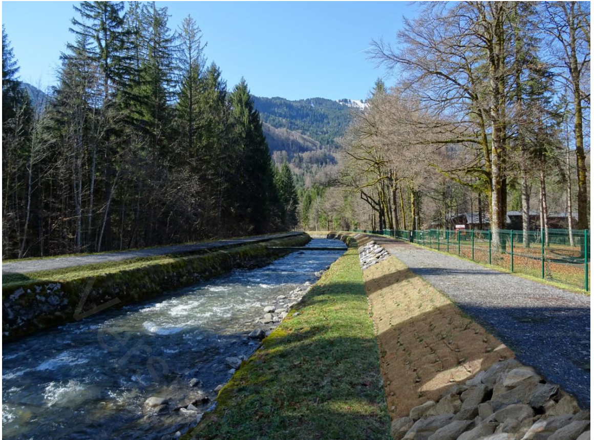
Figure 45: Clévieux - Solution de protection de talus en génie-végétal après travaux
