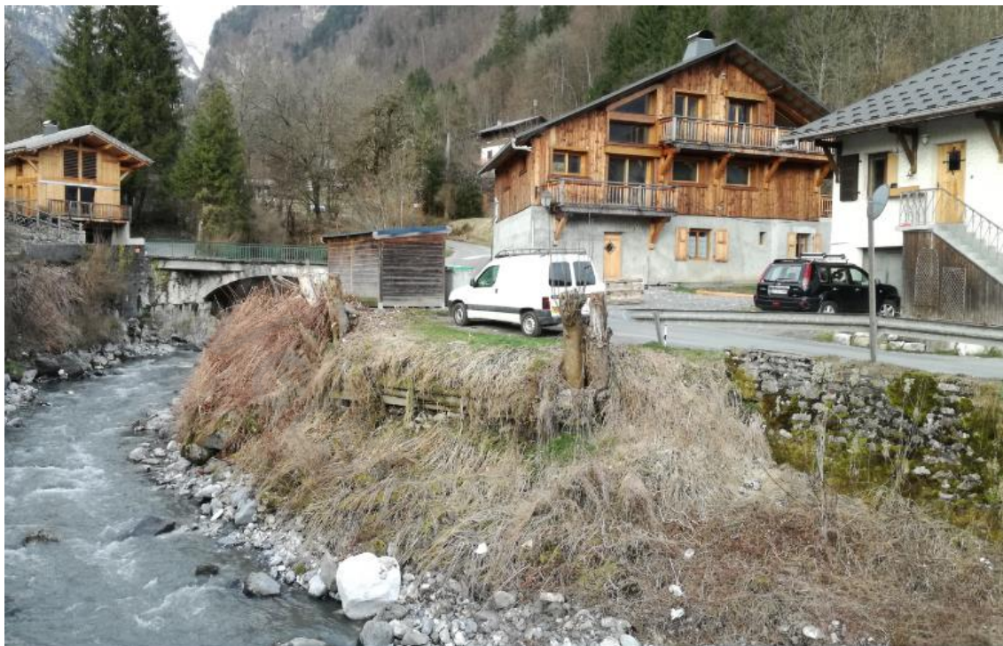
Figure 22: Clévieux rive gauche - Digue amont RD907 - Des2963
