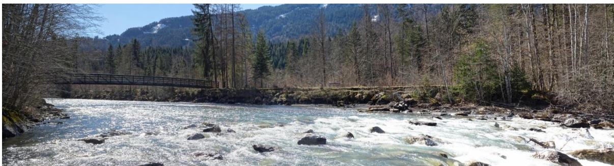
Vue 22 – La passerelle en bois élancée au-dessus du Giffre marque la fin de la séquence et un changement d'ambiance subtile où le cours d'eau s'élargi à nouveau à l'image de la séquence 3. Source : Egis
