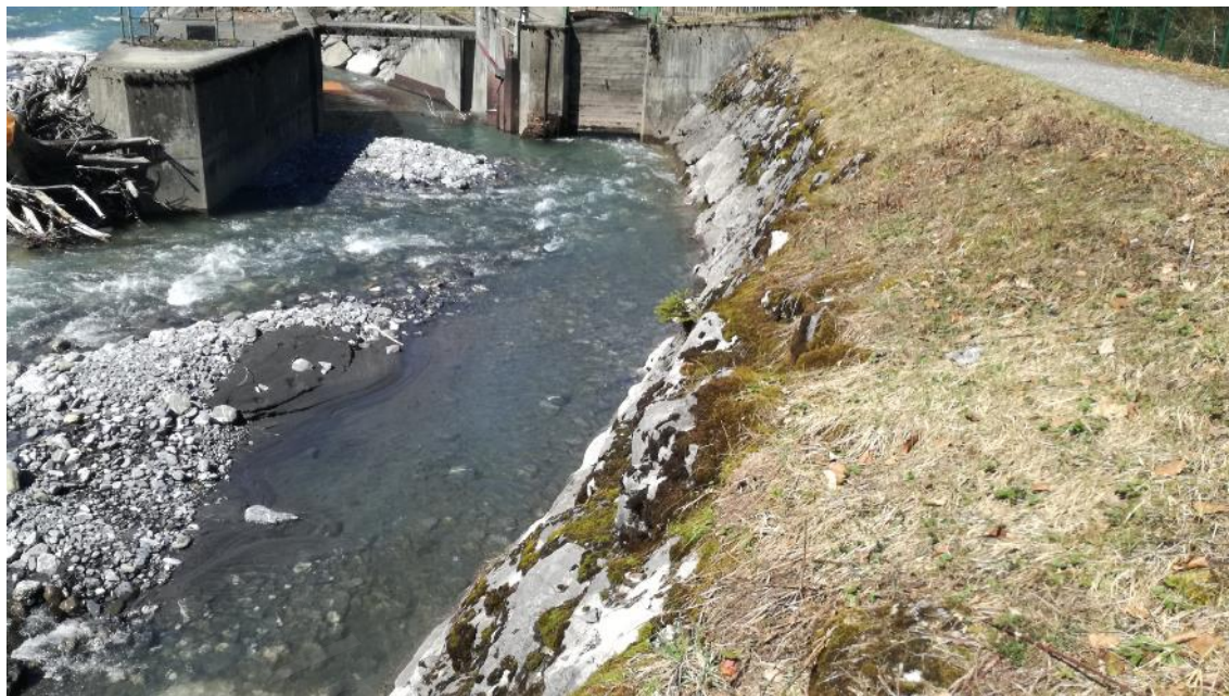
Figure 23: Exemple de réalisation d'enrochement bétonné en protection de talus - Prise d'eau du Lac aux Dames
