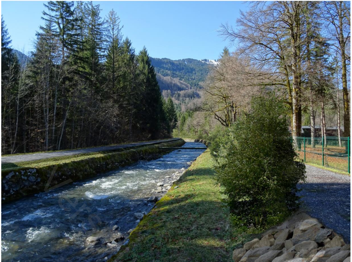
Figure 46: Clévieux - PT17 - Solution de protection de talus en génie-végétal 5 ans après travaux.
