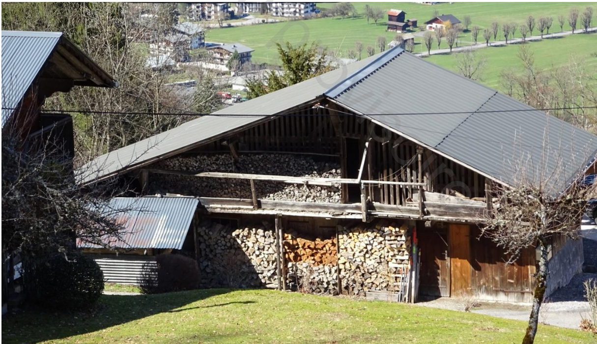
Figure 12 – Dépôt de bois de chauffage rappelant un opus incertum. Source : Egis
