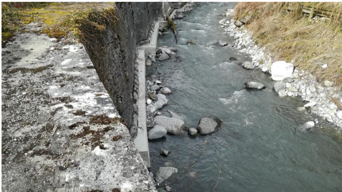
Figure 17: Exemple de reprise d'un désordre type érosion longitudinale en pied de digue - Travaux Janvier 2016 SM3A
