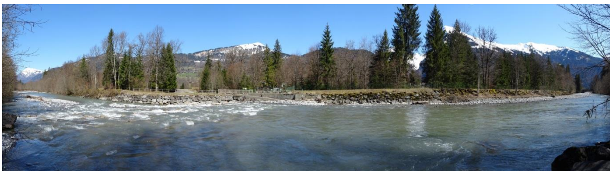
Vue 19 – Vue sur la ripisylve nord et sur l'ouvrage de bifurcation du Giffre permettant l'alimentation du Lac aux Dames. Source : Egis
