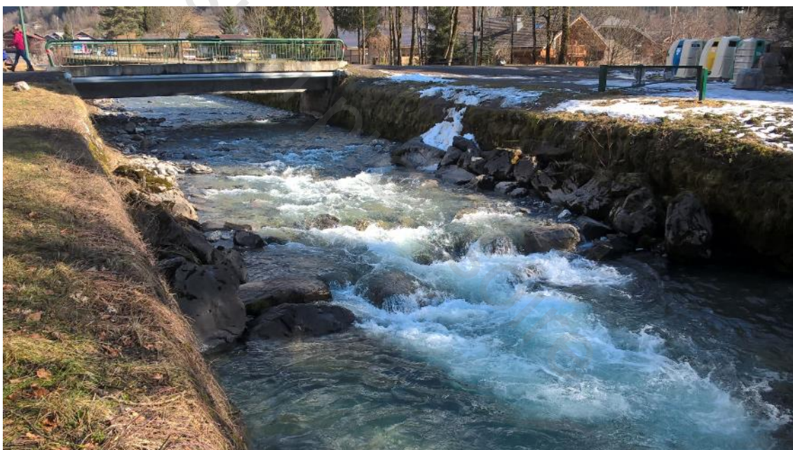
Figure 56: Clévieux seuil 5 - érosion en cours et création fosse de dissipation aval
