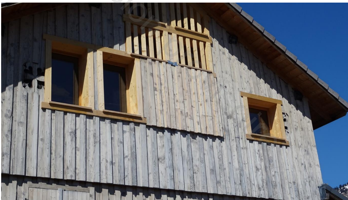
Figure 10 – Façade de maison traditionnelle récente. Bois orienter verticalement avec alternance de planches en débord ou rentrée. Source : Egis
