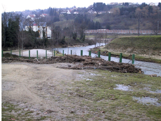
récupération et tri des corps flottants avant élimination
