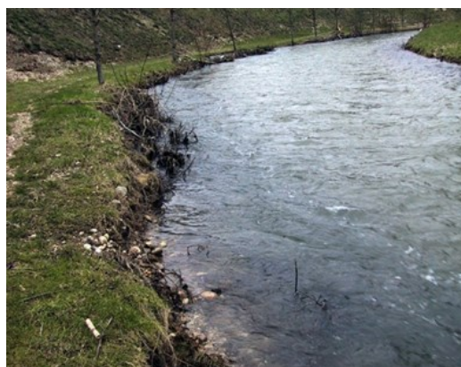
Une forte crue sur une technique végétale qui avait 5 ans. La berge a bien résisté mais a subi de petites dégradations, qu'il faut réparer: recéper les saules, retaluter, réensemencer et bouturer les espaces érodés. (en haut juste après la crue et en bas 4 mois après mais sans réparation)
