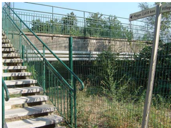
PASSERELLE DU PAS DE BONNE HEURE,
