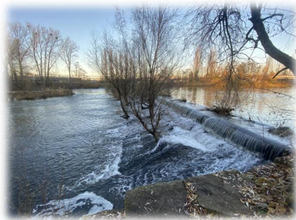
Figure 41 : Barrage des Bréviers (ROE22286)
