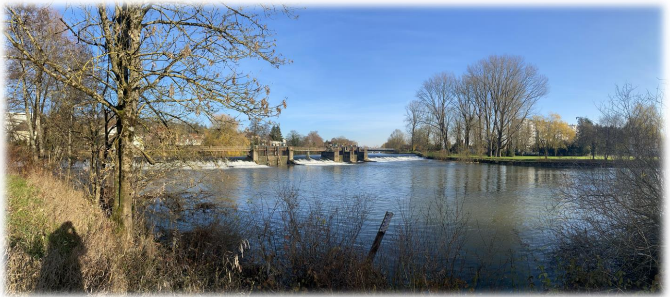
Figure 1 : Vue aval du barrage des Neufs Moulins
