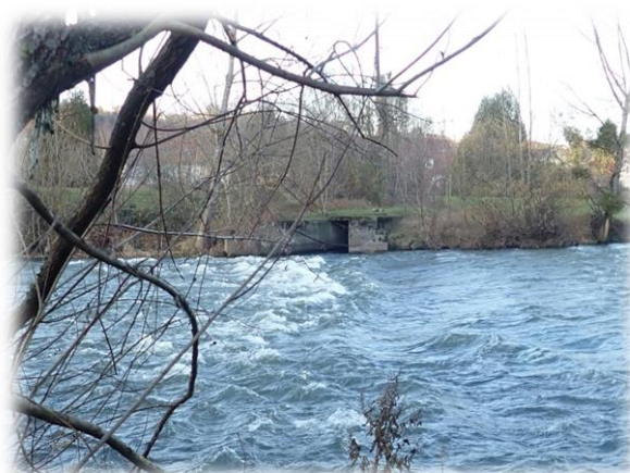
Figure 37 : Radier au droit du rejet de la STEP
