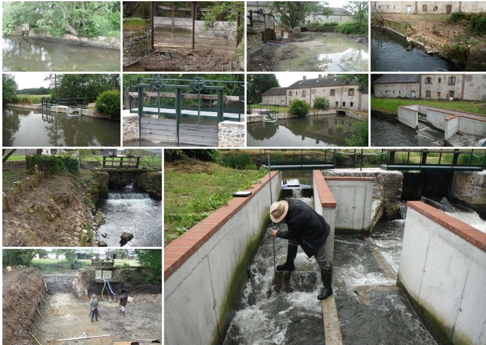
Restauration de la continuité écologique par équipement d'une passe à poissons multi-espèces à bassins successifs avec échancrures profondes, caisson végétalisé et restauration des organes vannés et du déversoir au moulin de Chambray à Gouville (27) - SIHVI - Etudes et maîtrise d'oeuvre RCE CE3E 2013
