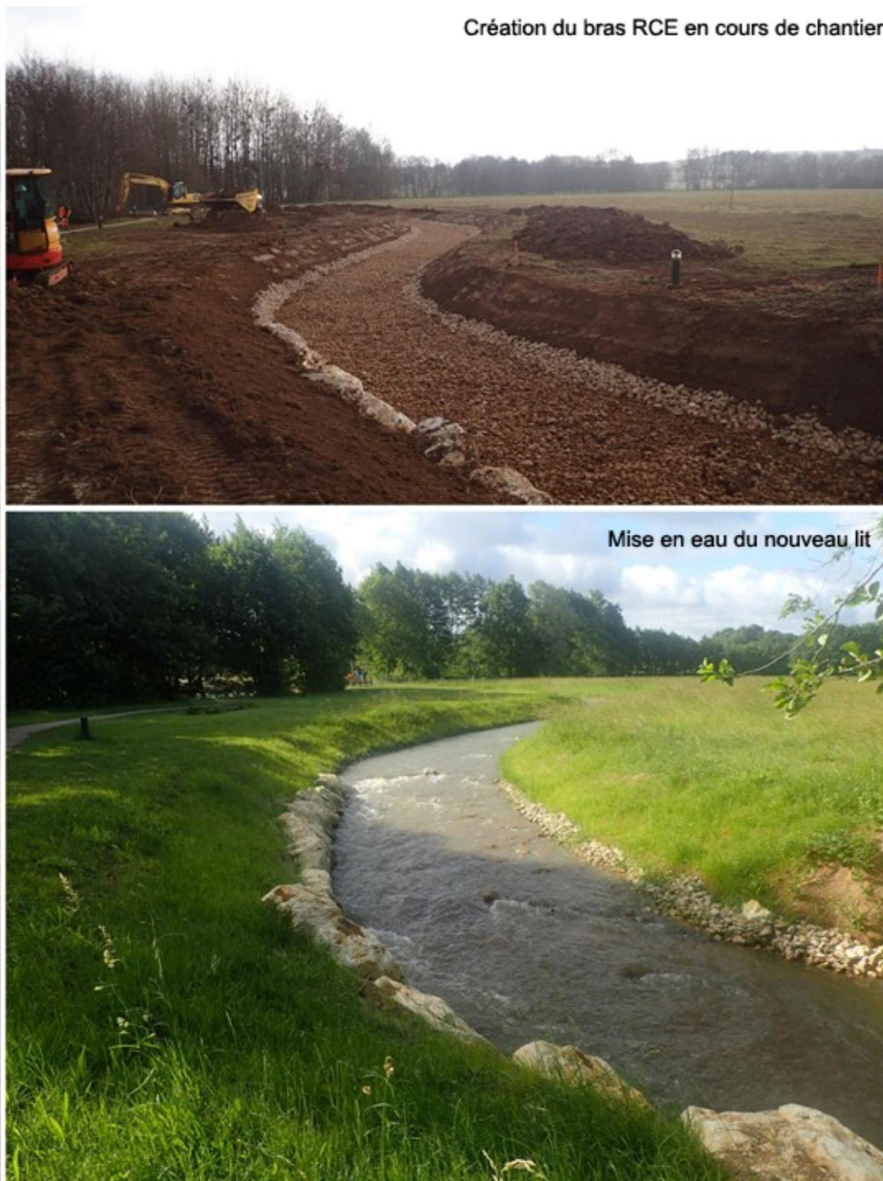
Figure 98 : Travaux de remise en fond de vallée de l'Ouanne au moulin de Chemin à Tréguères (45)
