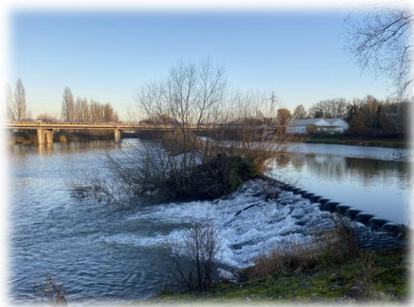
Figure 40 : Déversoir latéral séparatif (ROE97512 : barrage de Ludwigsburg)
