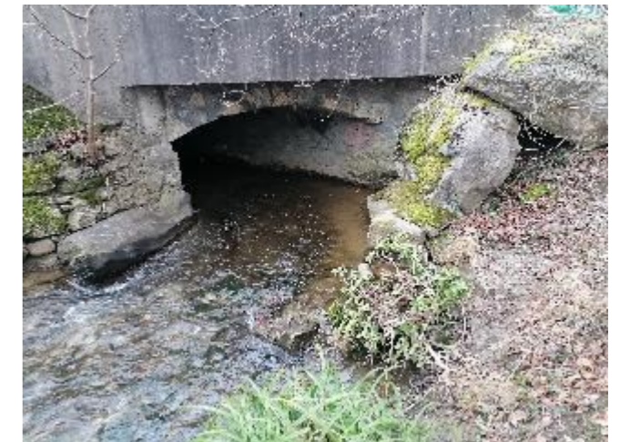
Figure 60: Ouvrage de traversée route d'accès Cité du Dadon (01/21)
