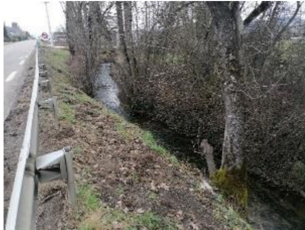
Figure 53: Dernier tronçon le long de la RD910 avant confluence avec le Boiran (01/21)
