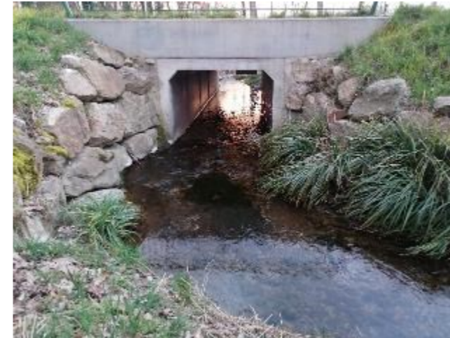
Figure 39: Pont de la RD53 - Vue amont (03/21)
