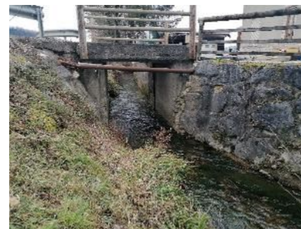
Figure 51: Traversée et enrochements en rive droite (01/21)
