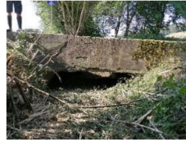
Figure 21: Pont du Martenay (07/20)
