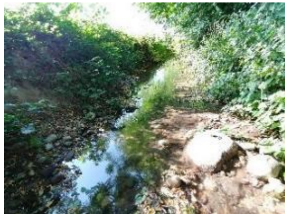
Figure 19: Linéaire en amont du pont de Conzier (07/20)
