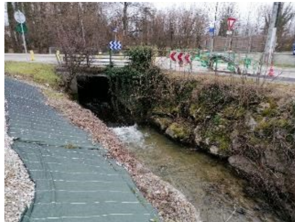
Figure 61: Aval route d'accès Cité du Dadon (01/21)
