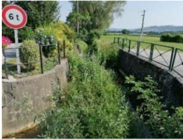
Figure 17: Bifurcation vers le Nord à l'aval du pont (07/20)
