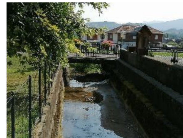
Figure 15: Pont à l'aval de l'école (07/20)
