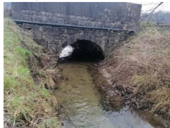
Figure 30: Vue aval ouvrage traversée RD910 (01/21)
