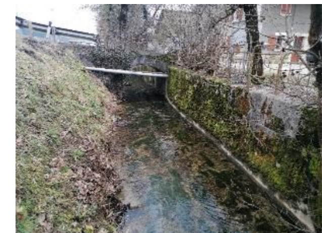
Figure 50: Accès aux habitations en rive droite avec mur béton (01/21)
