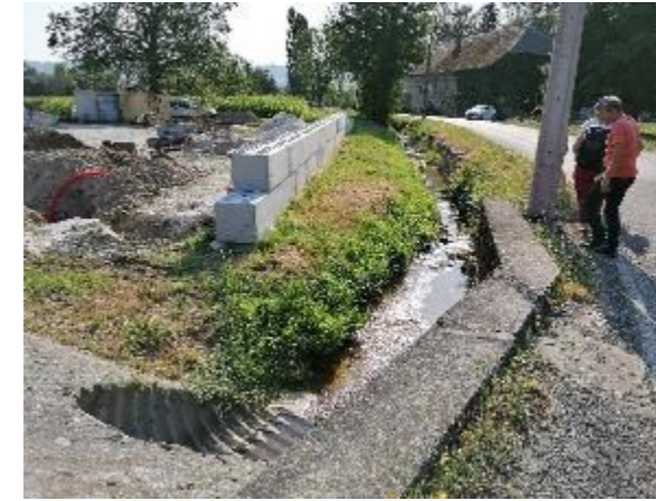
Figure 11: Aval traversée RD240 avec protection de berge (07/20)
