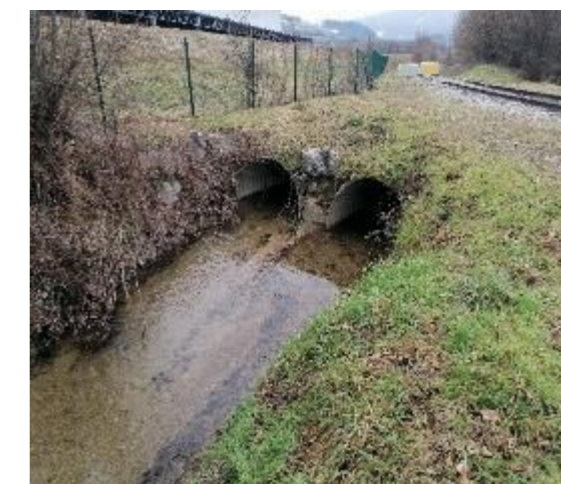
Figure 5: Conduites sous voie ferrée accès Système U (01/21)
