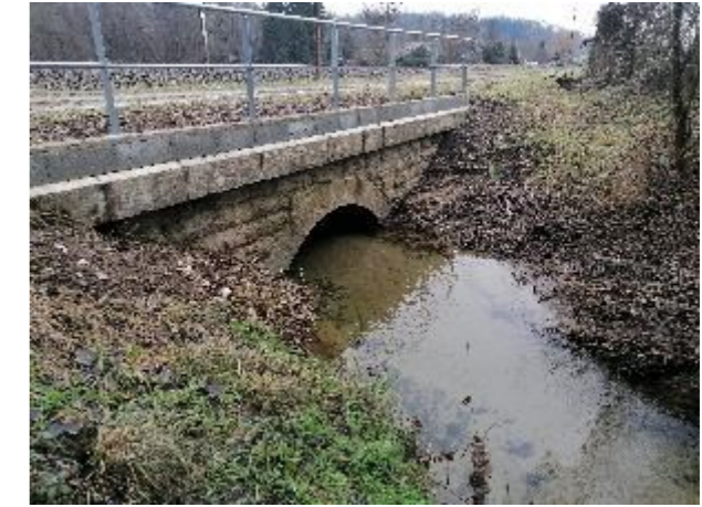
Figure 48: Ouvrage de traversée voie SNCF (01/21)
