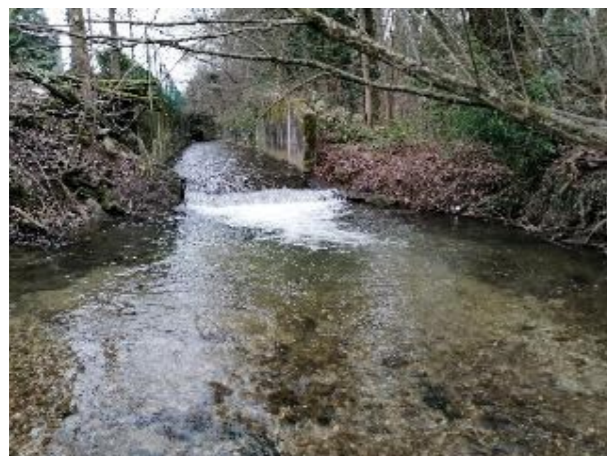
Figure 65: Aval section bétonnée avec seuil et important rejet EP en amont (01/21)
