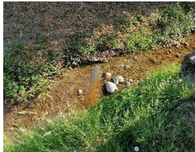
Figure 7: Traversée de conduite apparente (07/20)
