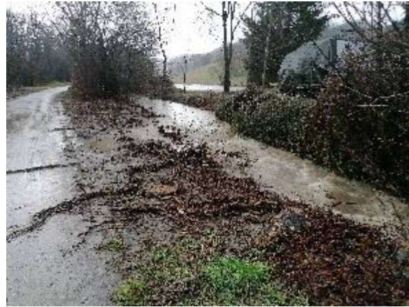
Figure 25: Débordement du Boiran en rive droite (01/21)
