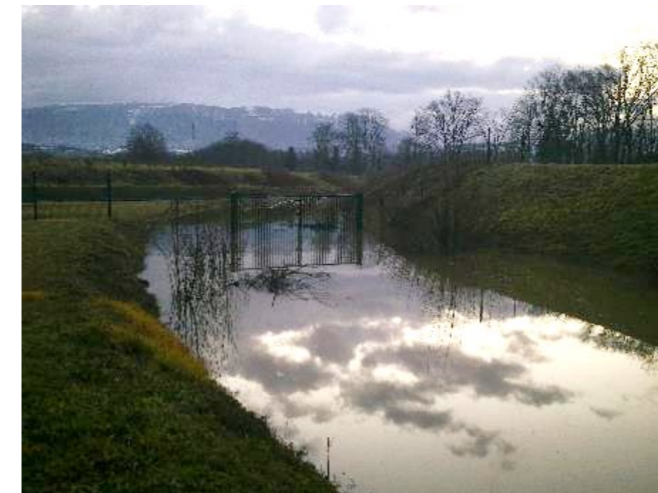
Figure 95: Voie ferrée inondée (06/01/2012)
