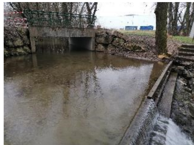
Figure 78: Pont avec seuil d'accès bras de décharge (01/21)
