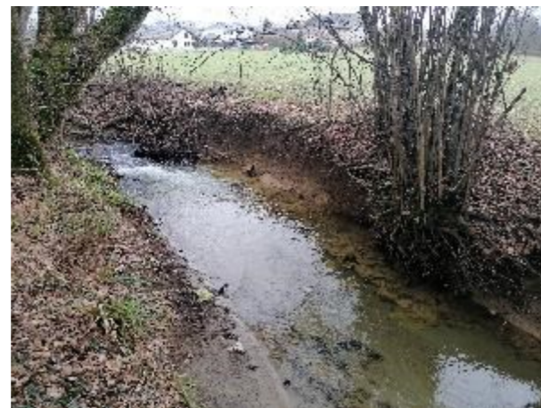
Figure 46: Tronçon le long du Système U, en amont des voies ferrées (01/21)
