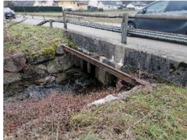
Figure 44: Pont amont Hameau de Balvay - Vue amont (01/21)
