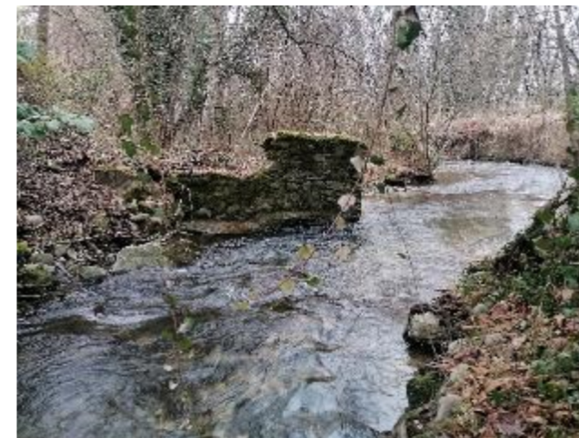
Figure 71: Ancien ouvrage formant un épi (01/21)
