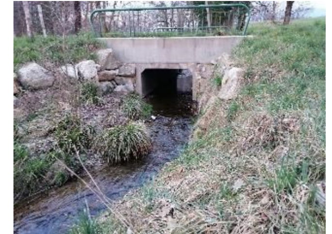
Figure 40: Pont de la RD53 - Vue aval (03/21)
