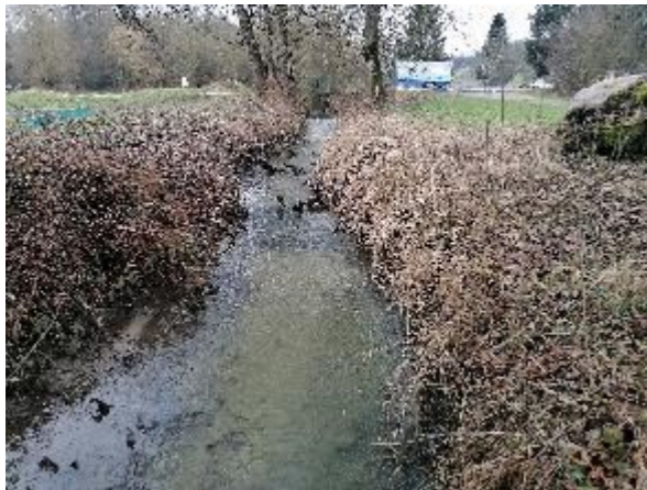
Figure 27: Aval pont de la Maladière (01/21)
