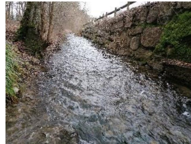
Figure 59: Tronçon en amont du pont d'accès Cité du Dadon (01/21)
