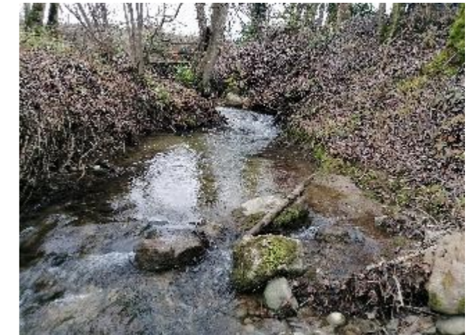
Figure 70: Dadon encaissé et seuil (01/21)
