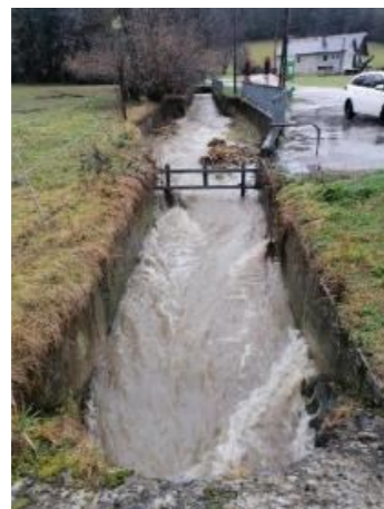
Figure 9: Piège à matériaux au niveau de Chez les Boissand (01/21)
