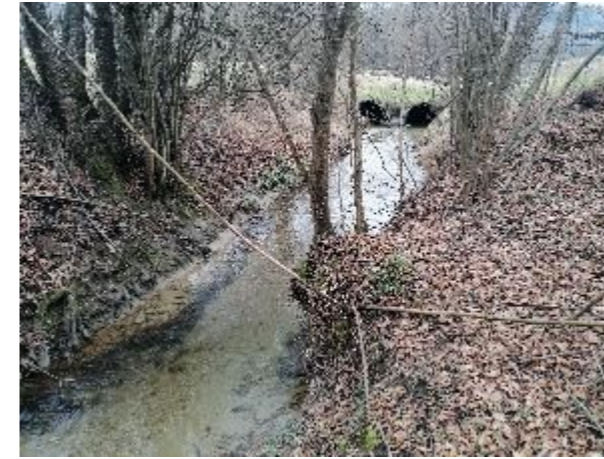
Figure 47: Ouvrage de traversée de la voie ferrée Système U (01/21)
