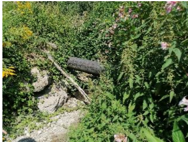
Figure 83: Conduite aérienne dans la seconde partie du bras de décharge (07/20)
