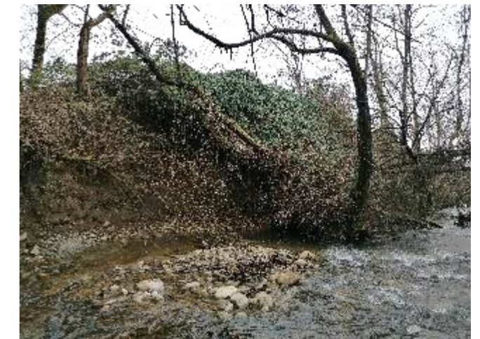
Figure 72: Importante érosion de berge (01/21)
