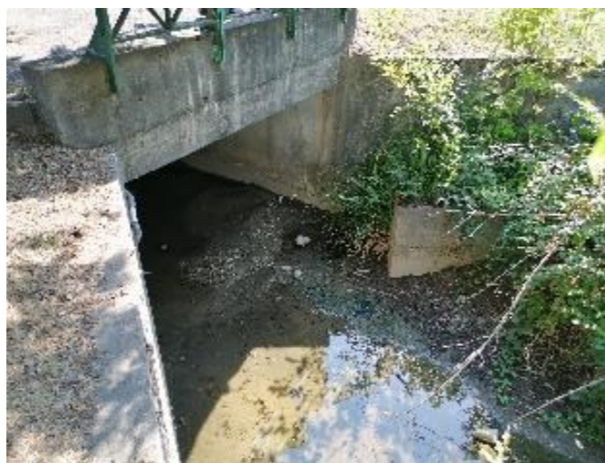
Figure 56: Ouvrage de traversée du rond-point en amont des services techniques (07/20)
