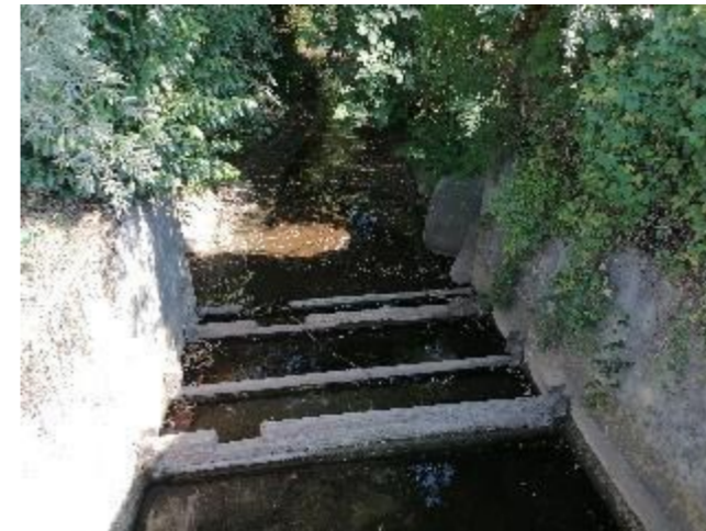
Figure 57: Ancienne passe à poisson en rive droite (07/20)
