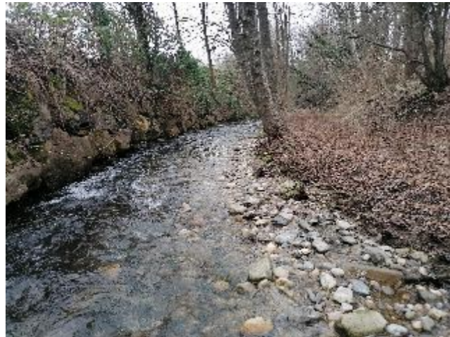
Figure 73: Protection de berge en rive gauche sur merlon (01/21)
