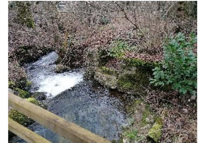
Figure 68: Chute en aval de la traversée de la RD3 (01/21)
