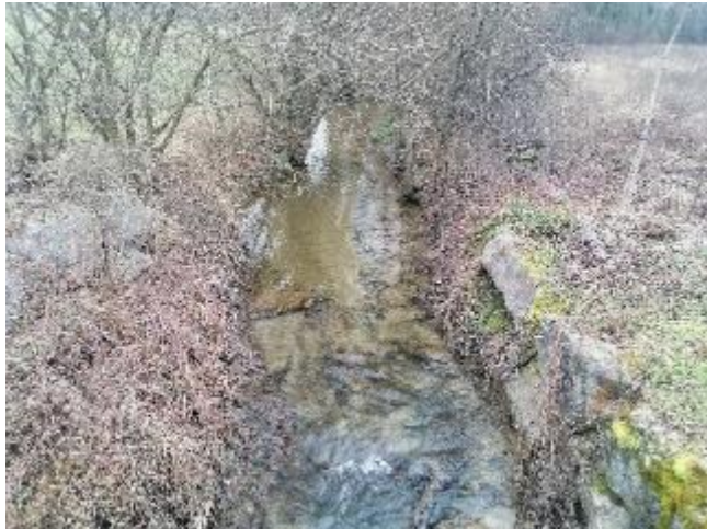
Figure 43: Tronçon amont du pont Hameau de Balvay (01/21)
