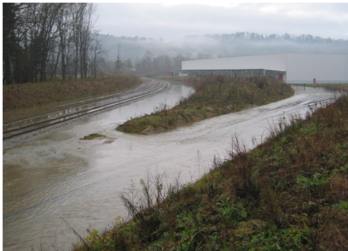
Figure 92: Prolongement des débordements vers l'aval, sens préférentiel d'écoulement sur la voie ferrée, contournement de la plateforme système U (15/11/2002)
