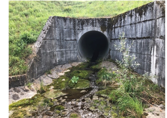
Photo 2: Ouvrage d'entrée du bassin
