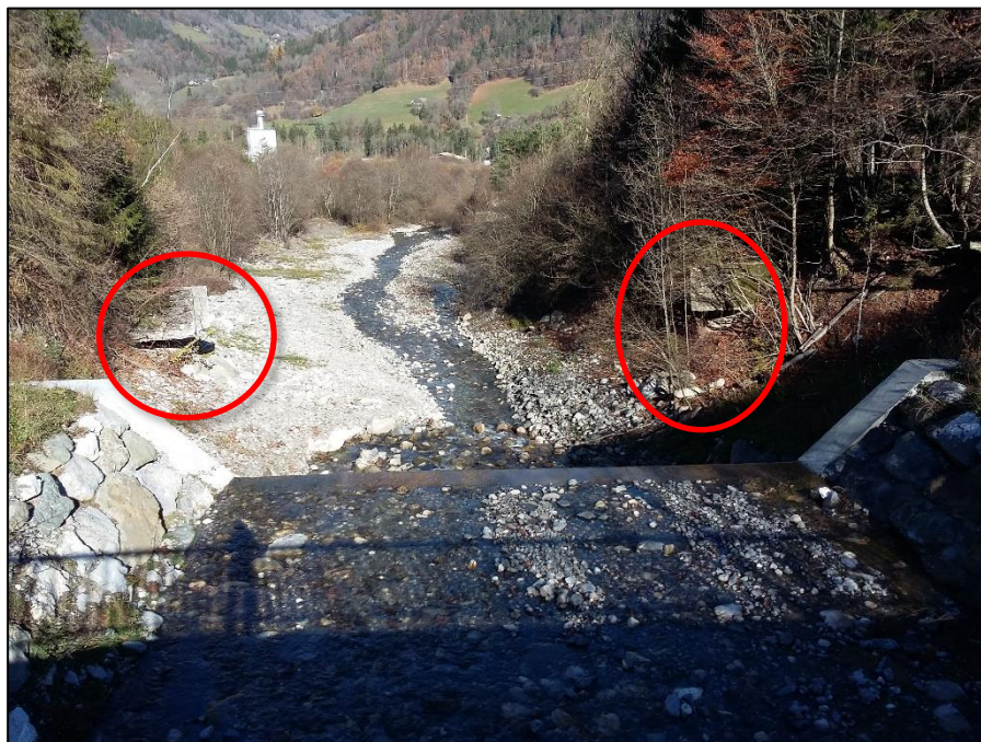
Figure 8 : épis perchés en aval du seuil de Bélossier (photographie BURGEAP 2017)
