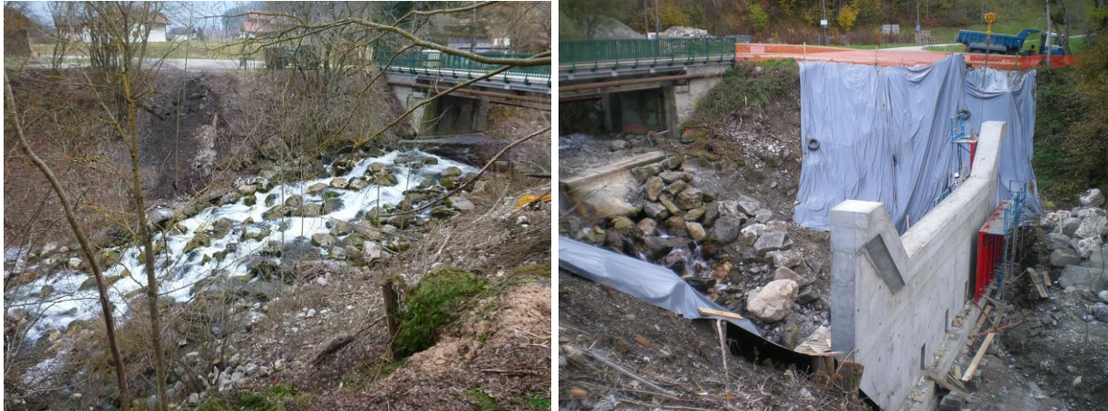
Figure 4 : ouvrage de stabilisation du pont de Bélossier en 2013 à gauche et pendant les travaux en 2016 à droite (photographie de gauche : BURGEAP, photographie de droite : Entreprise Lathuile Frères)
