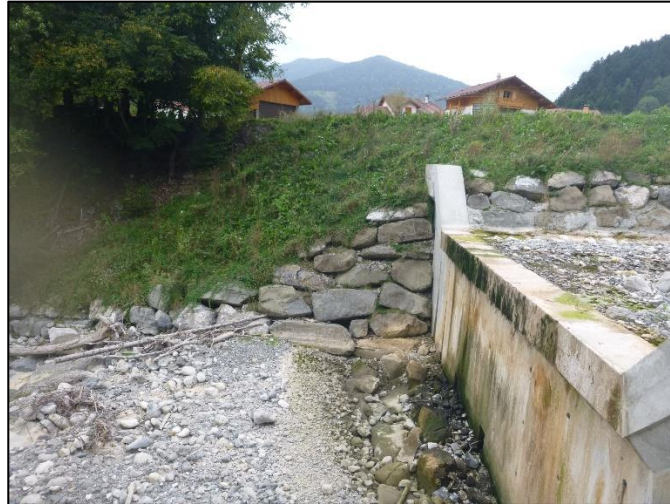
Figure 5 : seuil de stabilisation du pont de Bélossier (photographie BURGEAP 2018)
