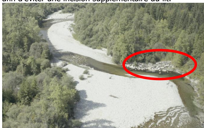
Epi secteur « amont » (site n°1), affouillé sur son flanc amont à la confluence Nant d'Alex
