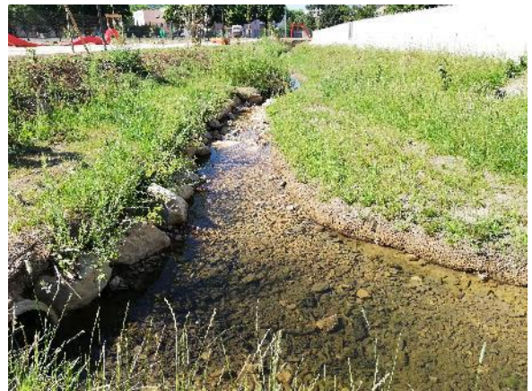
Principe des lits emboîtés le long d'enjeux sur rive
