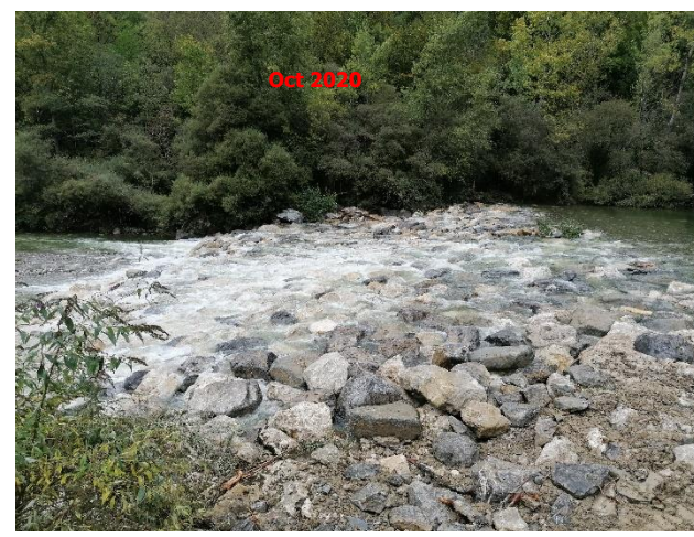
Dégradation de l'état du contre-seuil sur les 15 dernières années et confortement provisoire d'octobre 2020
