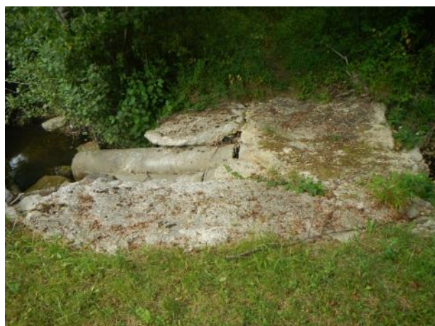
Passage à gué fortement dégradé provoquant des débordements en rive gauche vers la route et rive droite déconnectée
