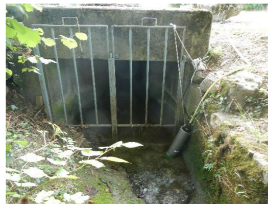
OH15 (entrée du tronçon canalisé)
