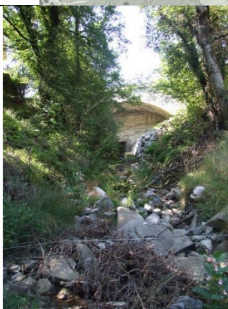
T1 en aval de OH9
