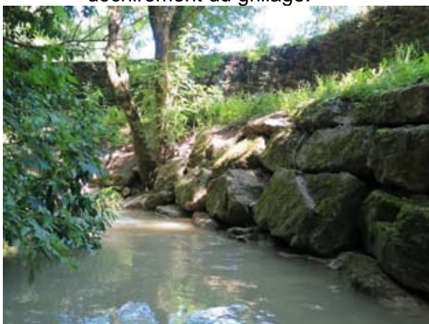
Protection en enrochements
