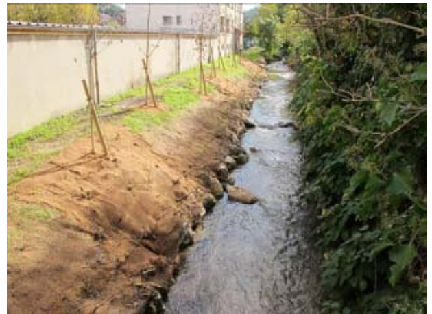
Démontage des enrochements, retalutage et plantation de reconstitution d'une ripisylve
