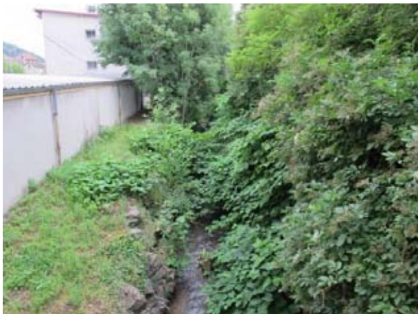
Enrochements de berge
