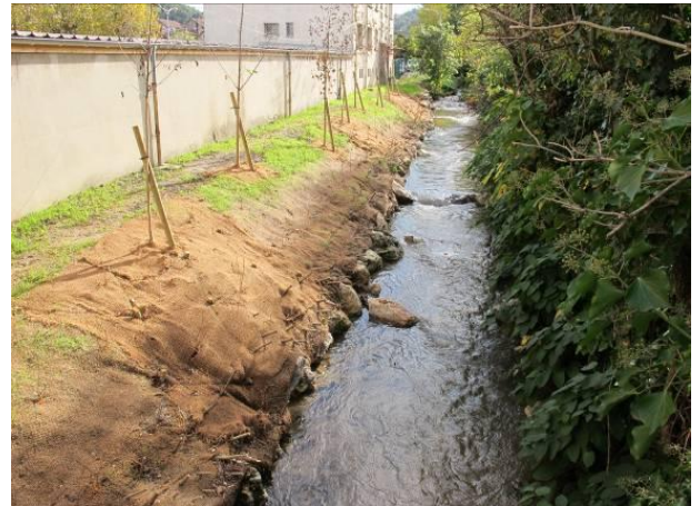
Démontage des enrochements, retalutage et plantation de reconstitution d'une ripisylve
