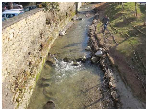
Diversification du Bion à Bourgoin-Jallieu par variation du profil en long ou en travers
