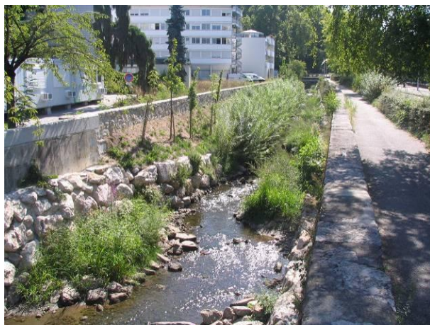
Renaturation de l'Albanne : structuration d'un lit vif diversifié sur un cours d'eau contraint avec renforcement des pieds des protections de berge
