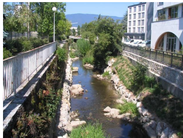
Renaturation de l'Albanne : structuration d'un lit vif diversifié sur un cours d'eau contraint avec renforcement des pieds des protections de berge
