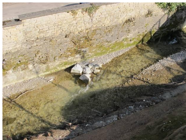
Diversification du Bion à Bourgoin-Jallieu par variation du profil en long ou en travers
