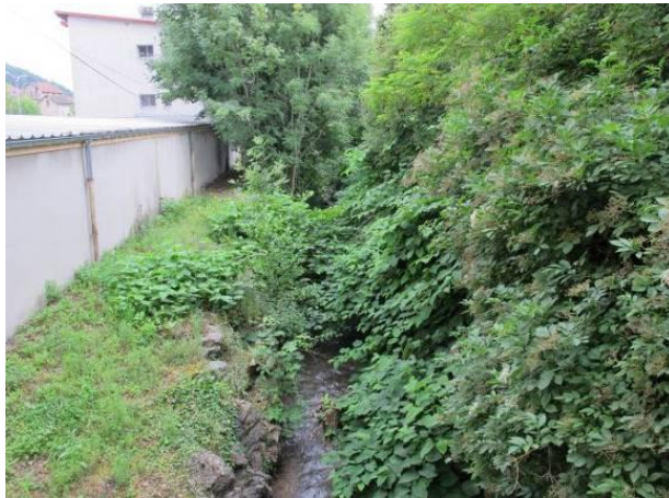
Enrochements de berge
