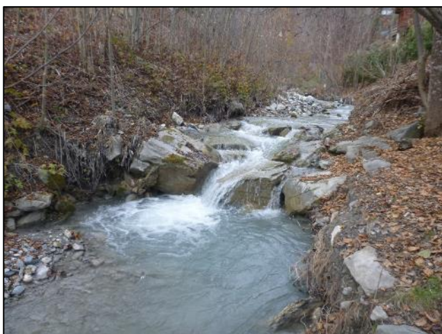
Figure 11 : Seuil de stabilisation du lit OH2 difficilement franchissable en raison de l'affouillement aval (BURGEAP – 20-11-2018)
