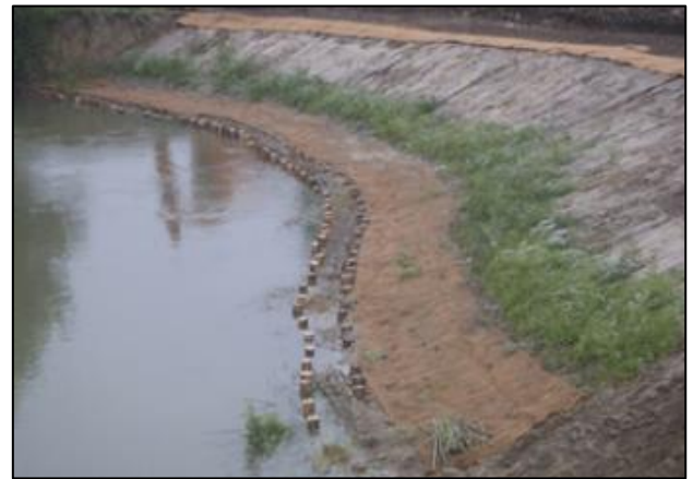
Figure 25 : Couche de branche à rejets et géotextile coco biodégradable posée en berge (source : smavas.fr)
