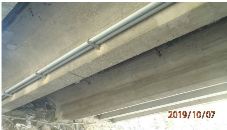
Figure 23 Le pont de la RD 89 en parfait état
