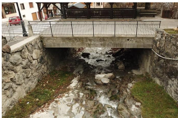
Pont de l'Eglise (RD89)
