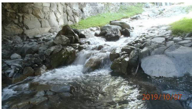
Figure 24 Le seuil sous le pont de la RD 89
