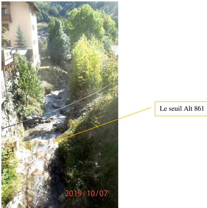
Figure 4 Vue générale du lit en aval de la route départementale
