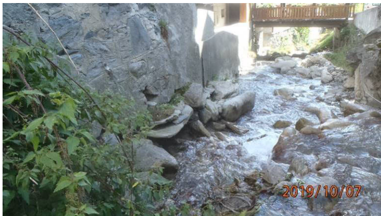
Figure 15 Le pied de berge de rive gauche assez sérieusement affouillé en amont de l'immeuble de bord de route
