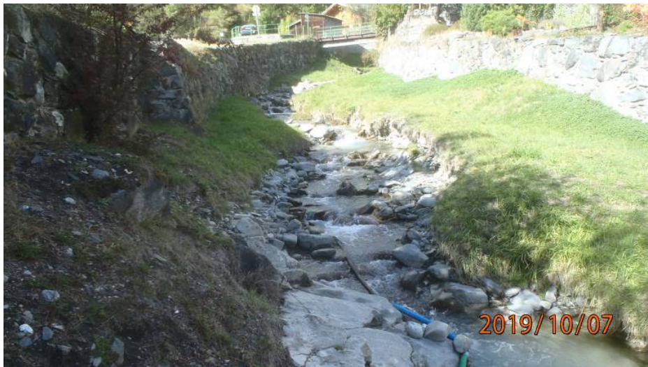
Figure 27 Le lit en équilibre juste en amont du seuil de la prise d'eau
