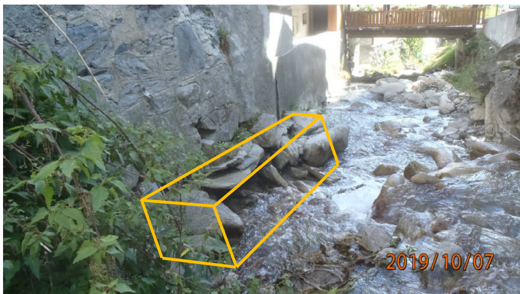
Figure 28 Principe de confortement de pied de digue
