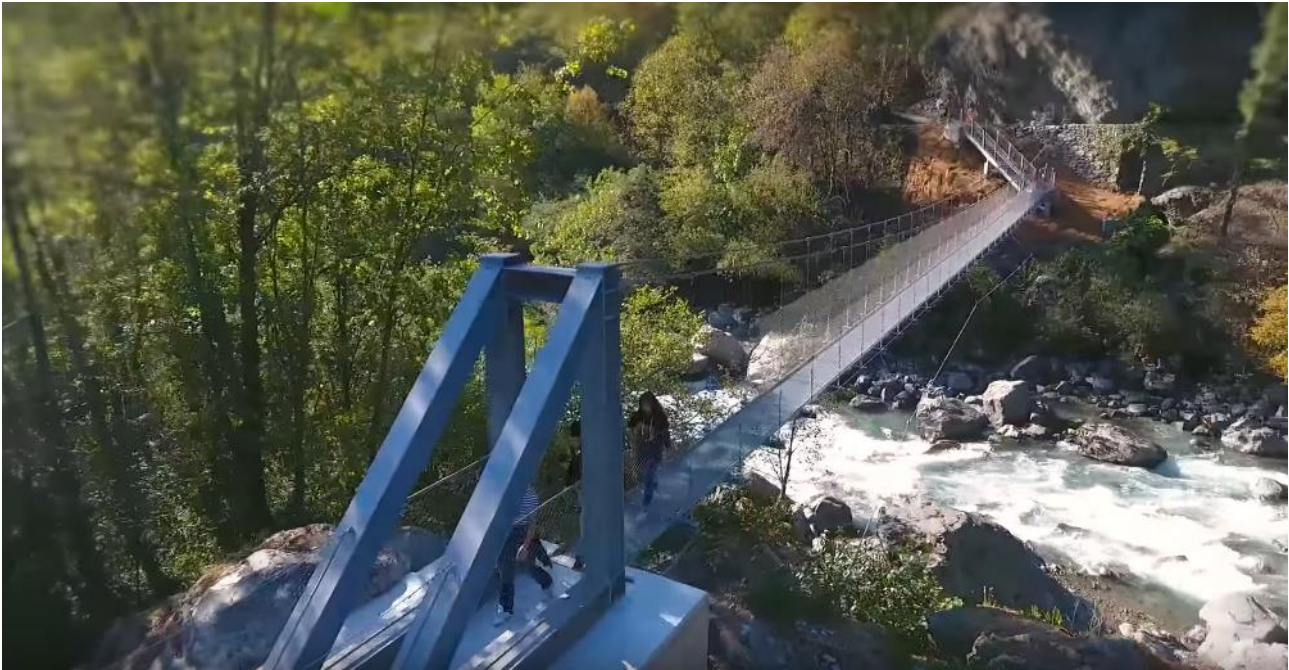
Figure 16 : Exemple de passerelle himalayenne sur la Romanche à Livet et Gavet (SYMBHI)
