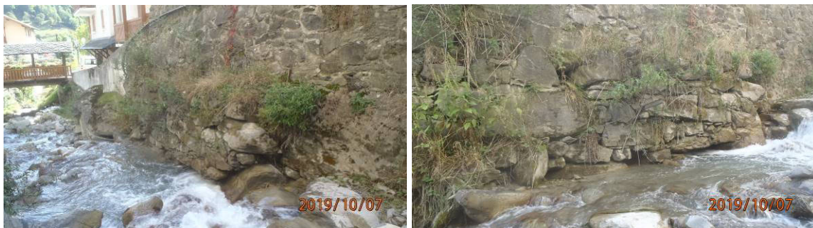
Figure 16 La berge de rive droite
