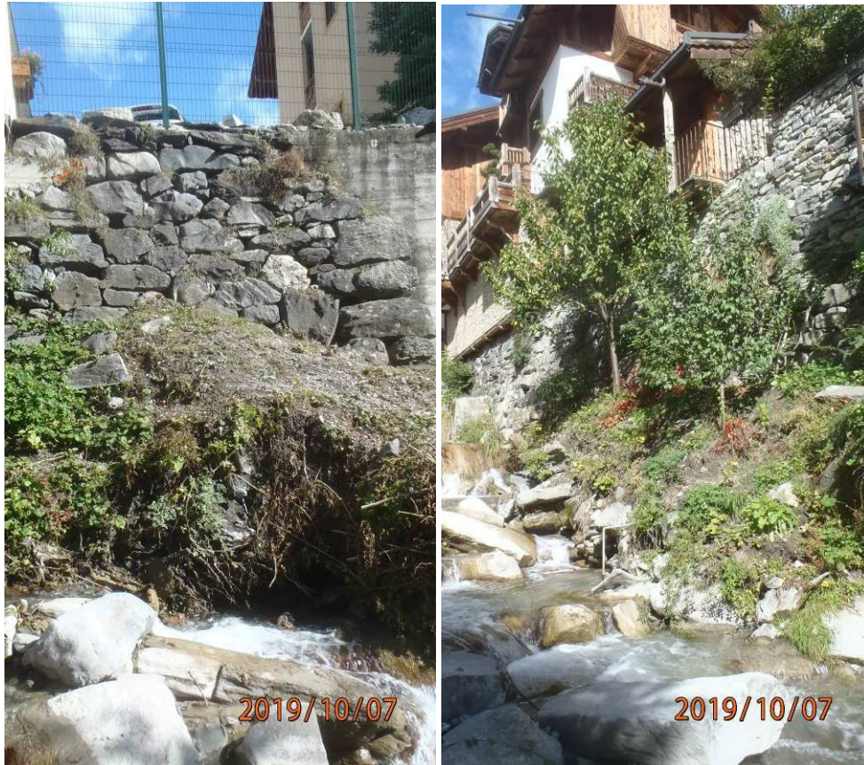
Figure 5 Les digues latérales en aval du seuil Alt 861 sous la RD
