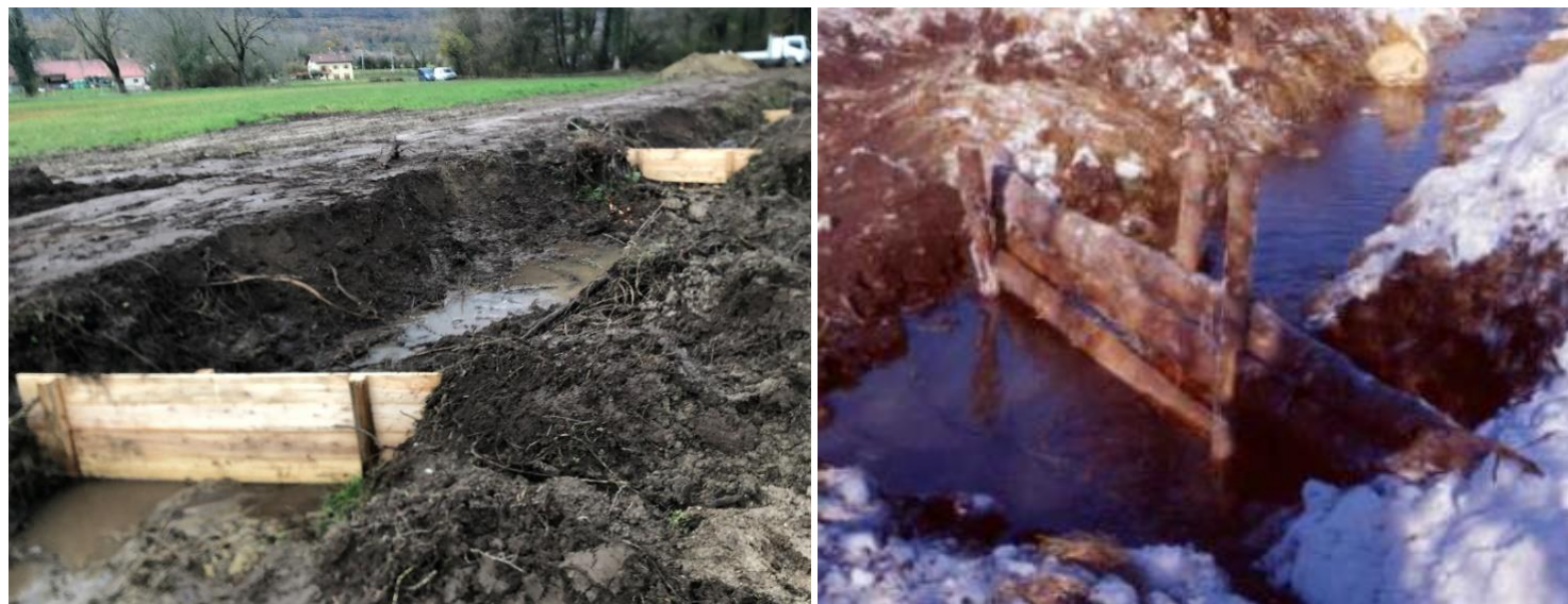
Figure 6.7 : Exemples de bardages rustiques permettant de limiter les sous écoulements dans les anciens lit rectifiés comblés.
