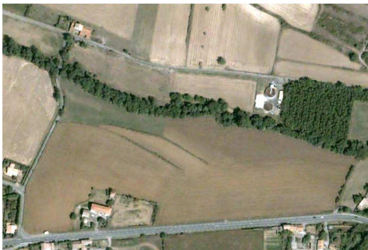
Illustration n° 1 : Vues aériennes de la station d'épuration
