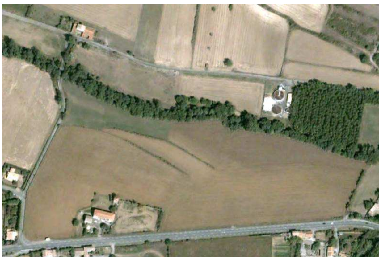
Illustration n° 1 : Vues aériennes de la station d'épuration
