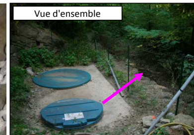
Rejet au Fossé
