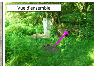
Rejet au Fossé
