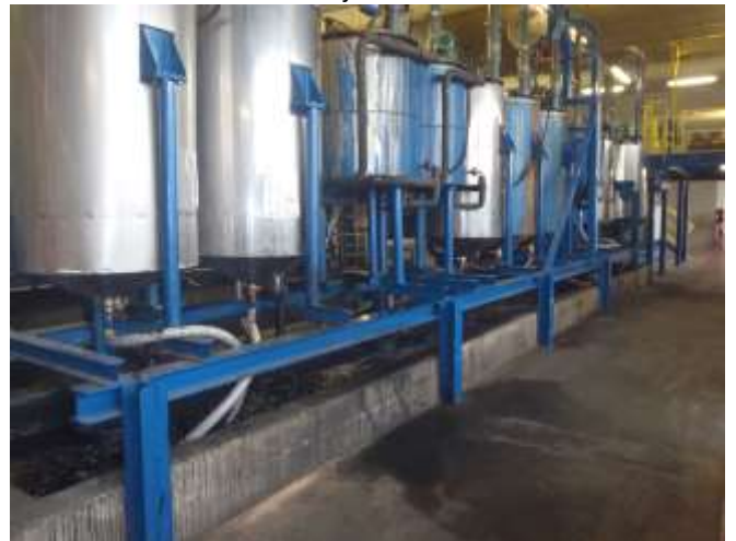
Vue d'ensemble des installations
