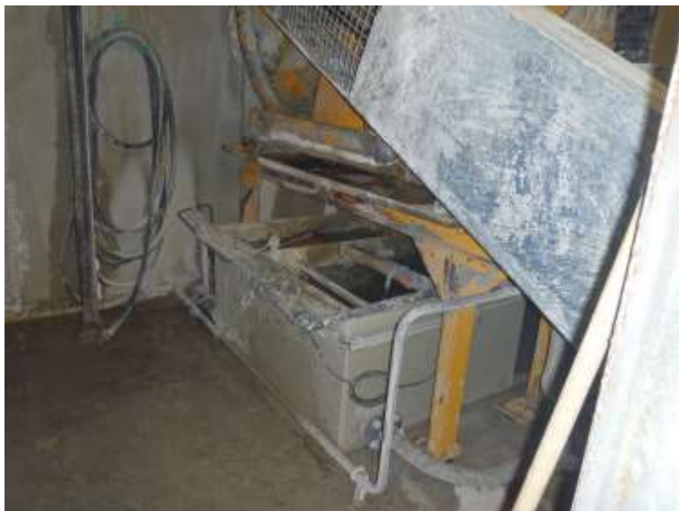
Vue des installations
