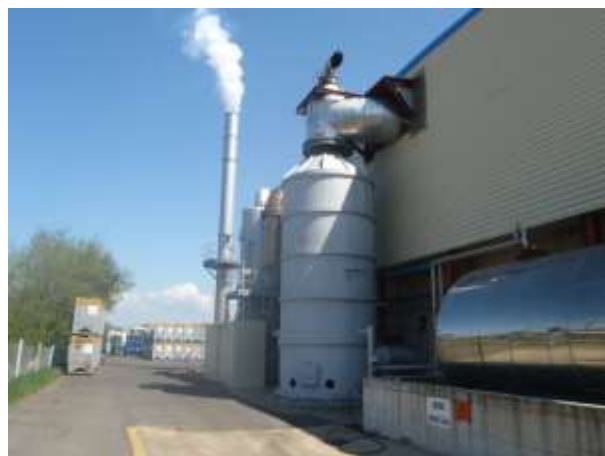
Etape de neutralisation
