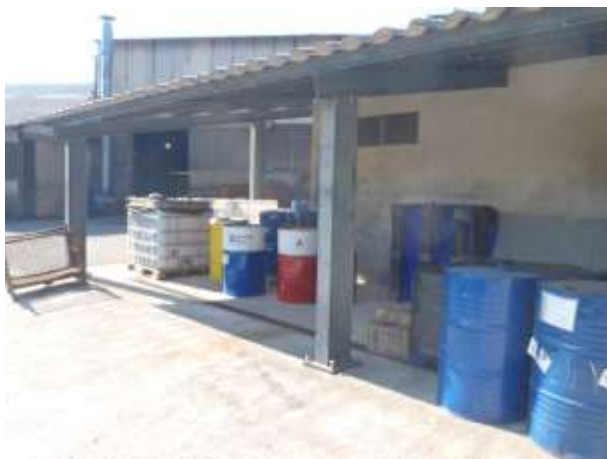
Stockage des produits liquides, sous abri et sur rétention
