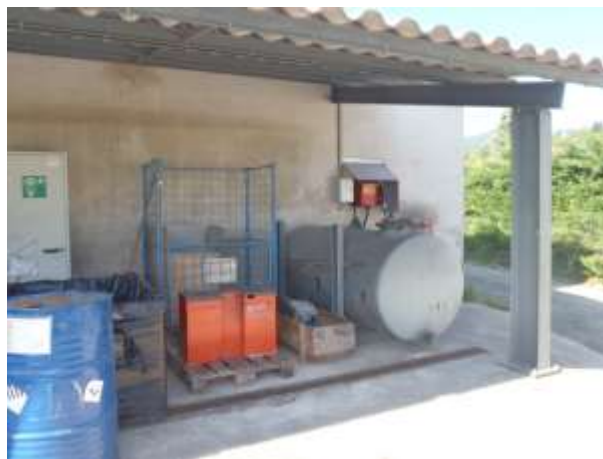
Stockage des produits liquides, sous abri et sur rétention
