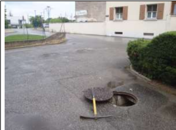
Point de rejet des eaux usées vers le réseau collectif
