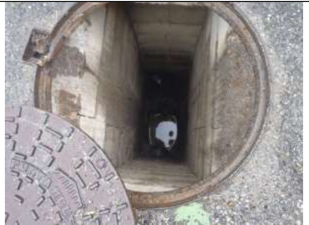
Vu de dessus du regard de branchement
