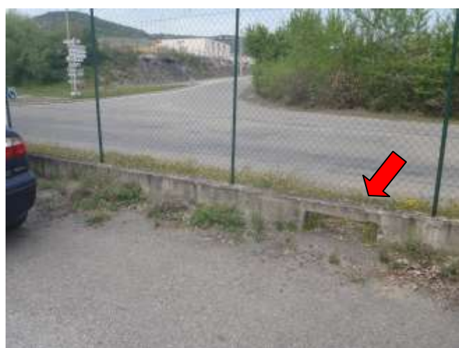
Regard de branchement au Nord de la parcelle
