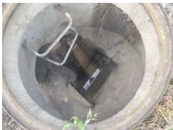
Point de rejet des eaux usées domestiques à l'assainissement collectif
