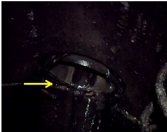
Infiltration au niveau du regard 40 (Emboitement et virole) \approx 0.2 \text{ m}^3/\text{h}
