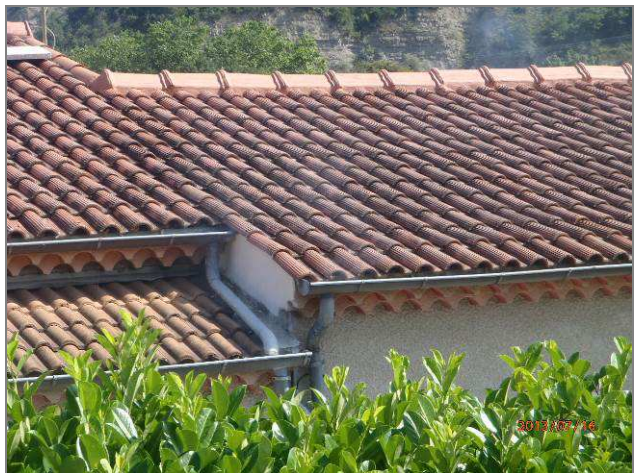
Illustration n°7: Photos d'anomalies à la fumée : Boîte non étanche (G) et gouttière raccordée (D)
