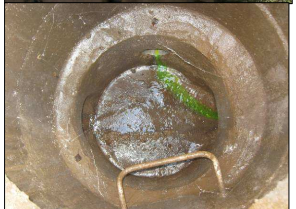
3 - Validation de la connexion hydraulique à l'aide de colorant
