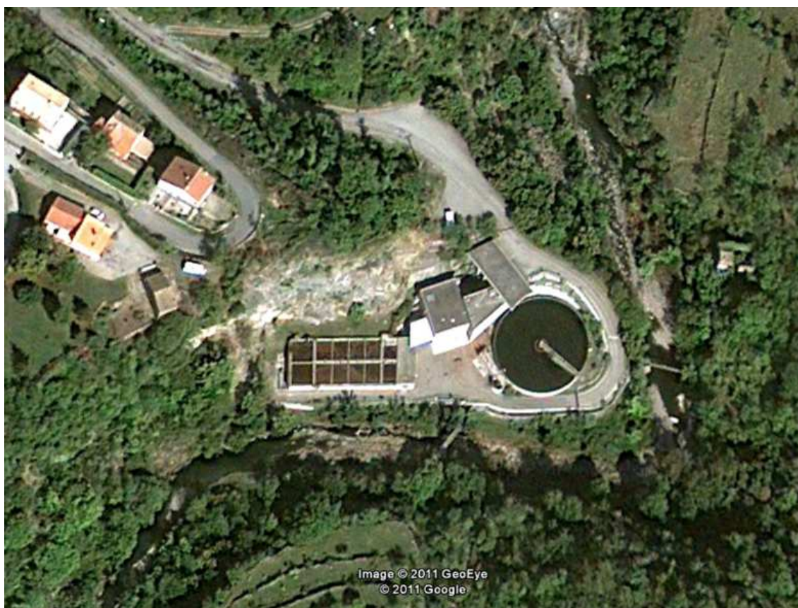
Illustration n° 2 : Vues aériennes de la station d'épuration intercommunale
