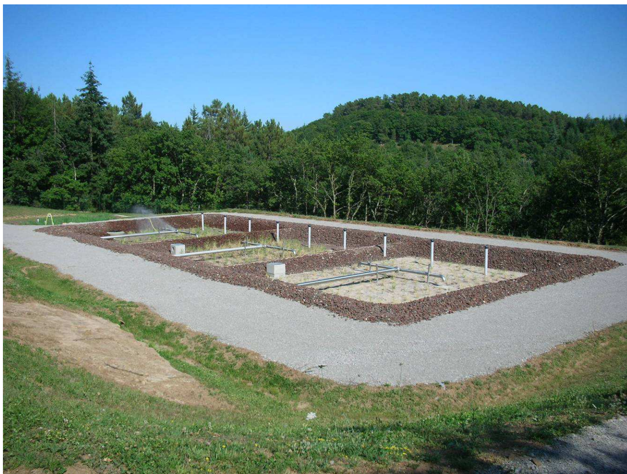
Illustration n° 3 : Vues aériennes de la station d'épuration du Haut Lyas
