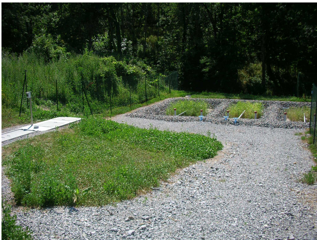
Illustration n° 3 : Vues aériennes de la station d'épuration de Creysseilles
