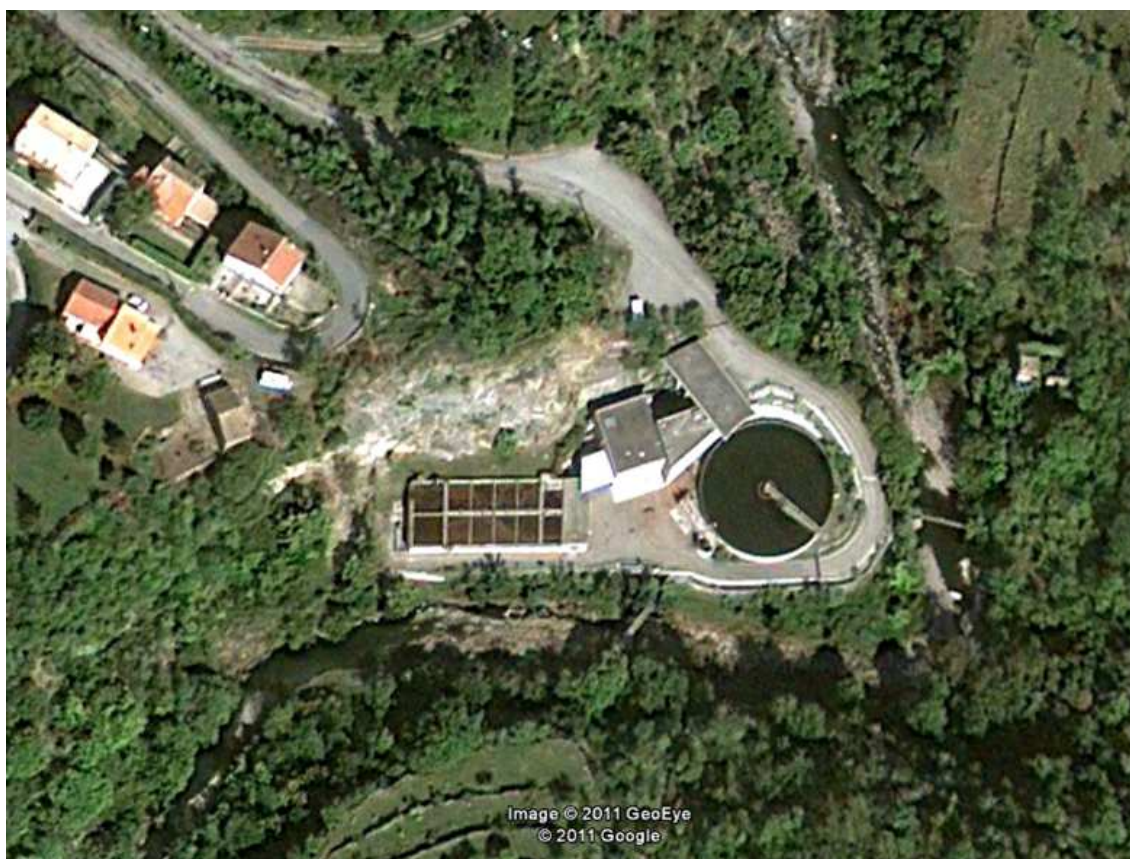
Illustration n° 2 : Vues aériennes de la station d'épuration
