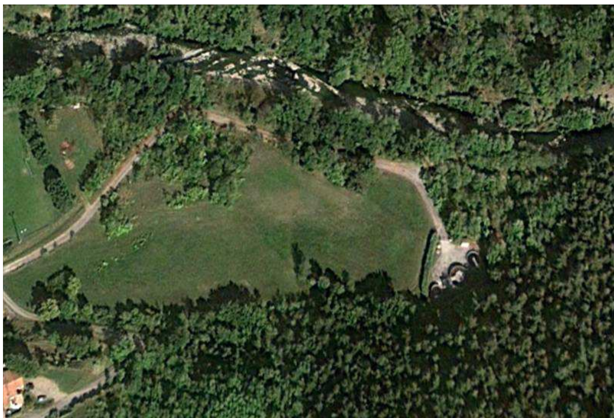
Illustration n° 1 : Vues aériennes de la station d'épuration
