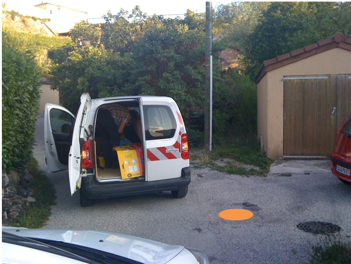
Vue extérieure du RV68, implanté Impasse de l'Ouvèze
