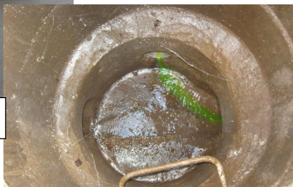
3 - Validation de la connexion hydraulique à l'aide de colorant
