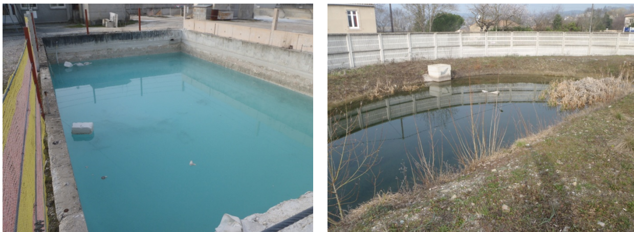
Figure n°10 : Delta Préfabrication - Vue des bassins de décantation et de récupération des eaux de pluie
