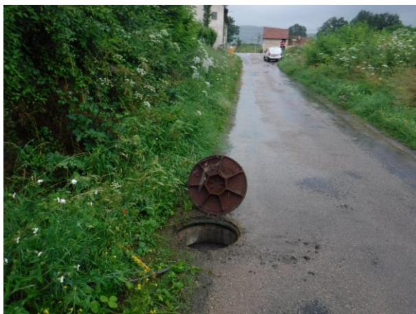
DO 1 – Vue extérieure
