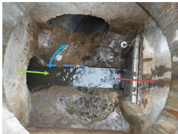
DO 1 – Vue intérieure
