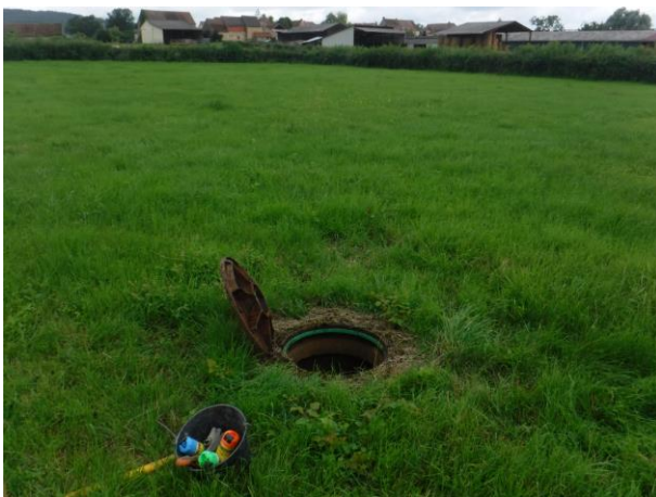
DO 2 – Vue extérieure
