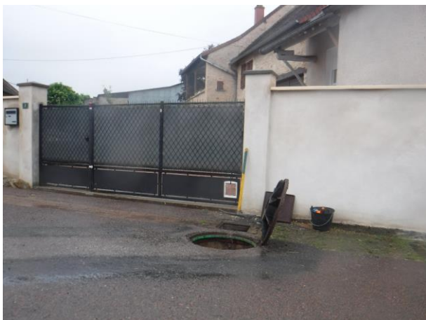
DO 4 – Vue extérieure
