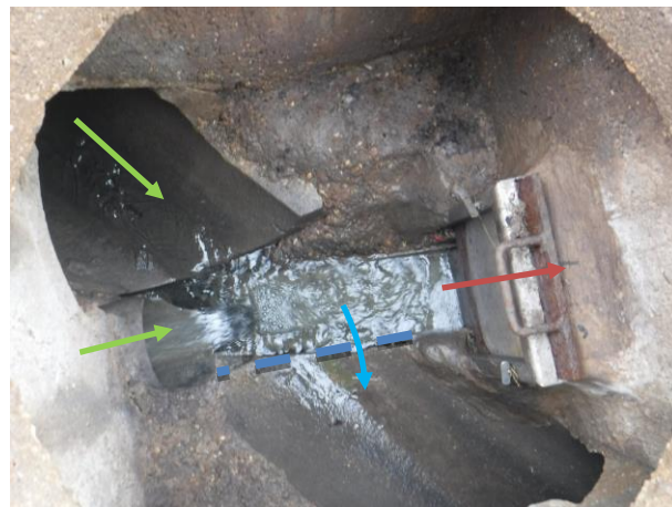
DO 2 – Vue intérieure
