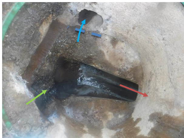
DO 4 – Vue intérieure
