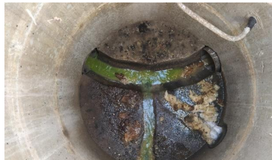
3 - Validation de la connexion hydraulique à l'aide de colorant
