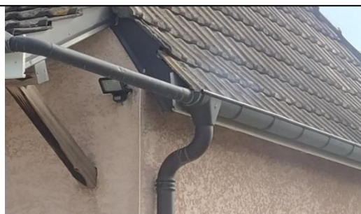
2 - Identification de tous les organes laissant s'échapper la fumée
